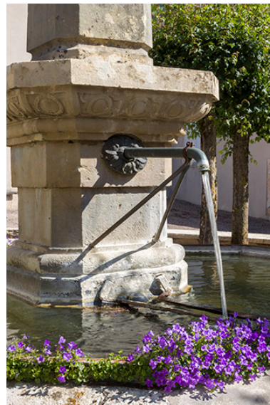
Détail de la sortie d'eau. Phot. Sonia Dourlot IVR43_20157000308NUC2A
