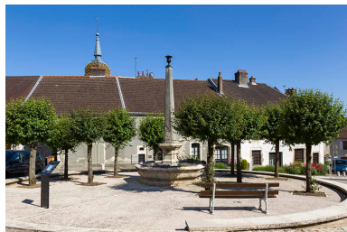
Vue d'ensemble. Phot. Sonia Dourlot IVR43_20157000306NUC2A
