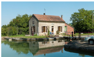
Vue du site d'écluse depuis l'amont. Phot. Pierre-Marie Barbe-Richaud IVR26_20112103928NUC4AQ
