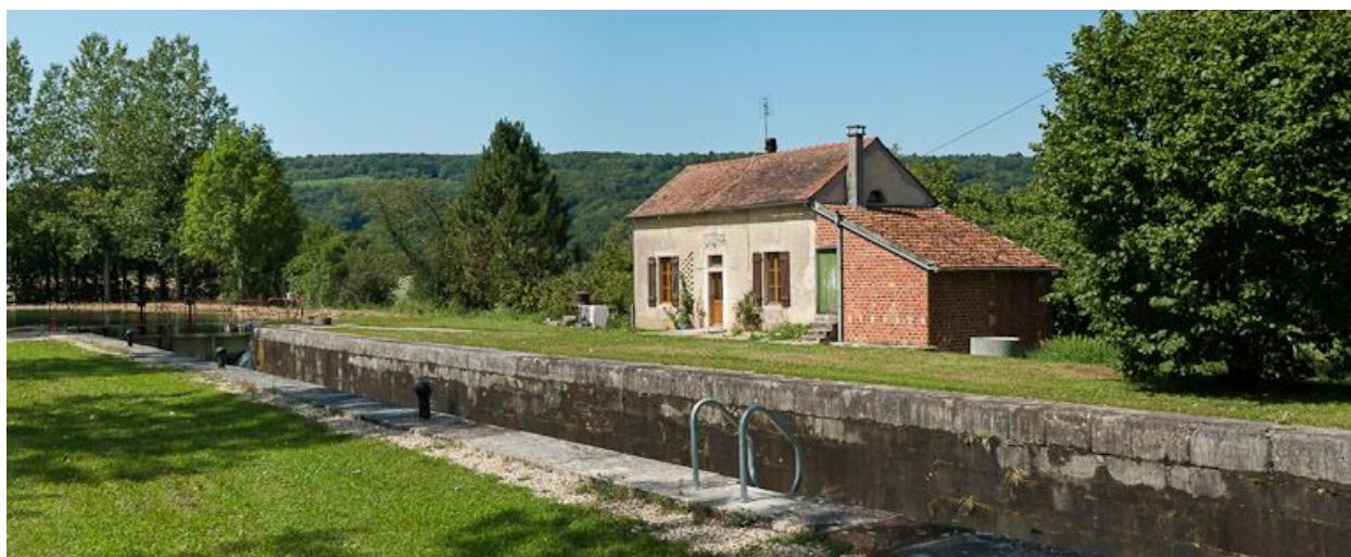
Vue d'ensemble du site d'écluse.
