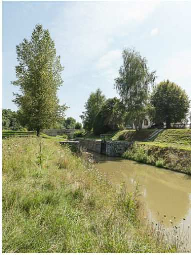
Vue du site d'écluse.
