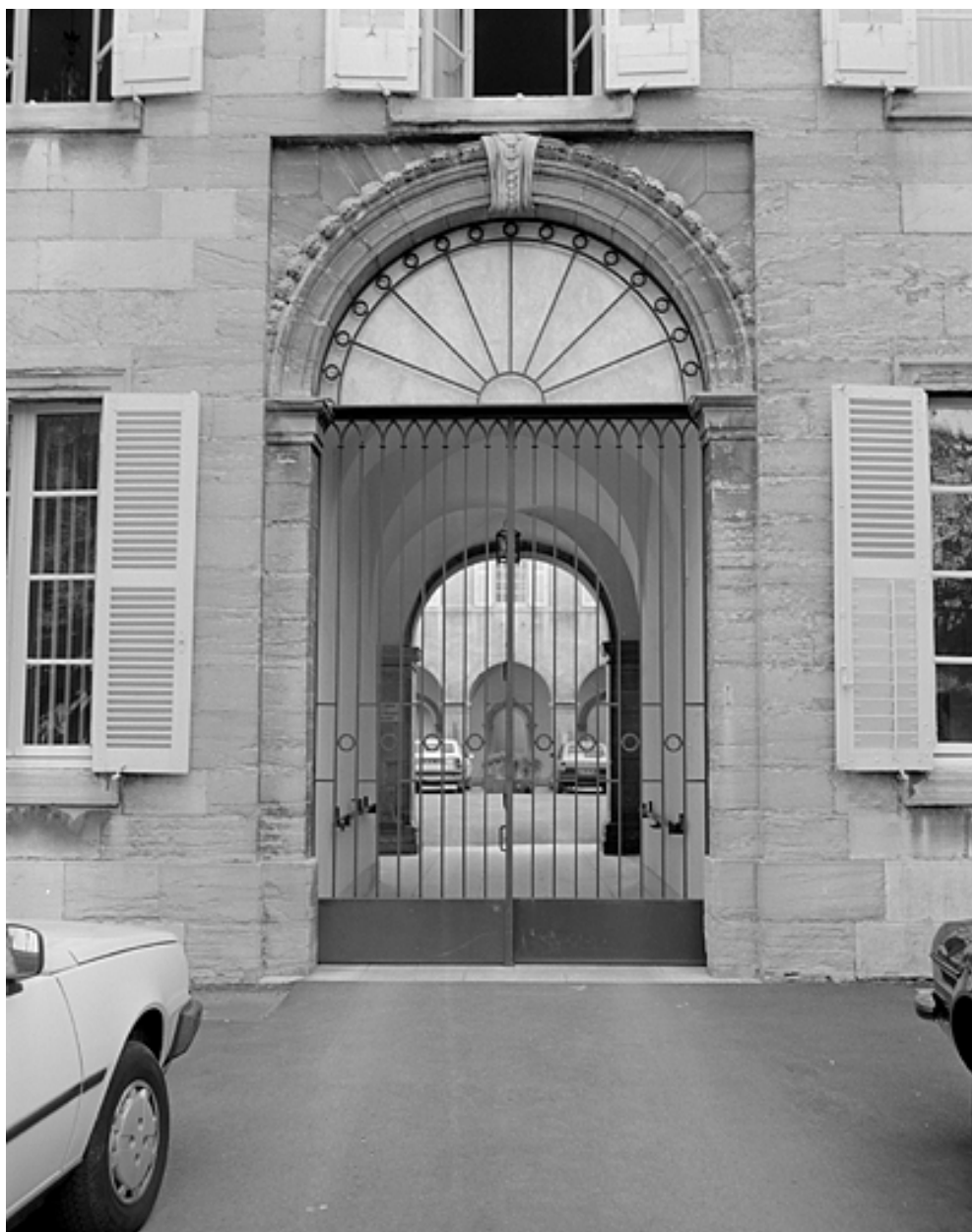
Portail d'accès au cloître.
