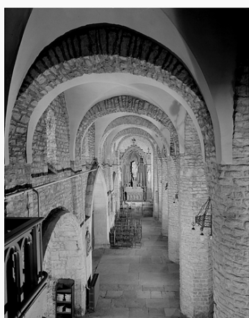
Eglise Saint-Désiré. Vaisseau latéral nord, vue générale.
