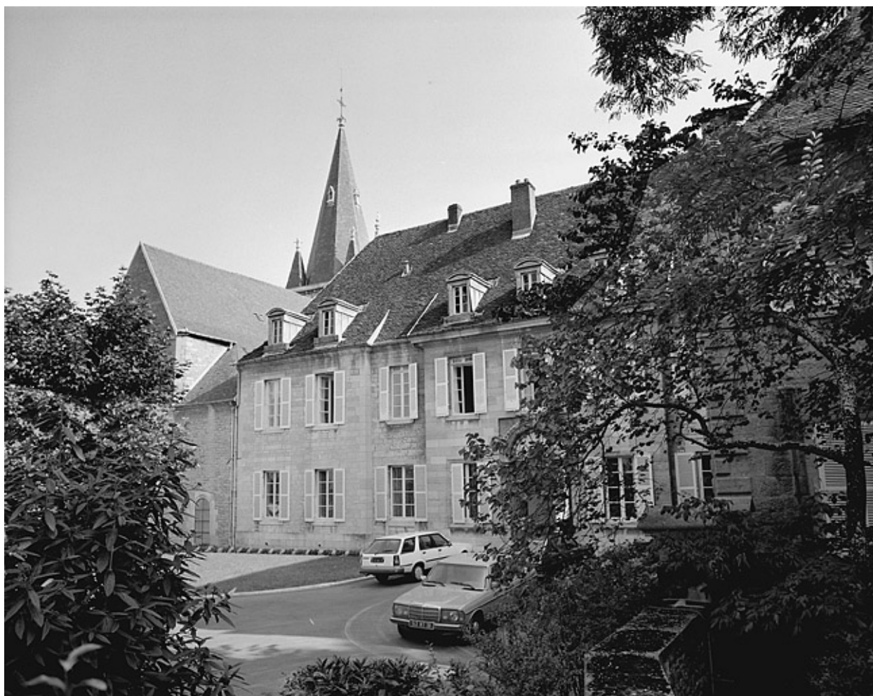
Cour d'honneur : détail du bâtiment.
