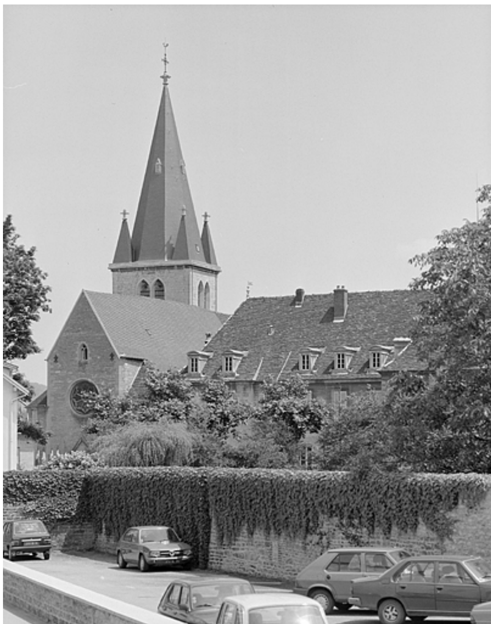
Eglise Saint-Désiré, vue générale depuis l'ouest.
