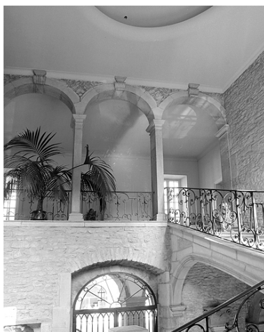
Bâtiments conventuels. Escalier : dernière volée et palier. Phot. Yves Sancey IVR43_19833900533X
