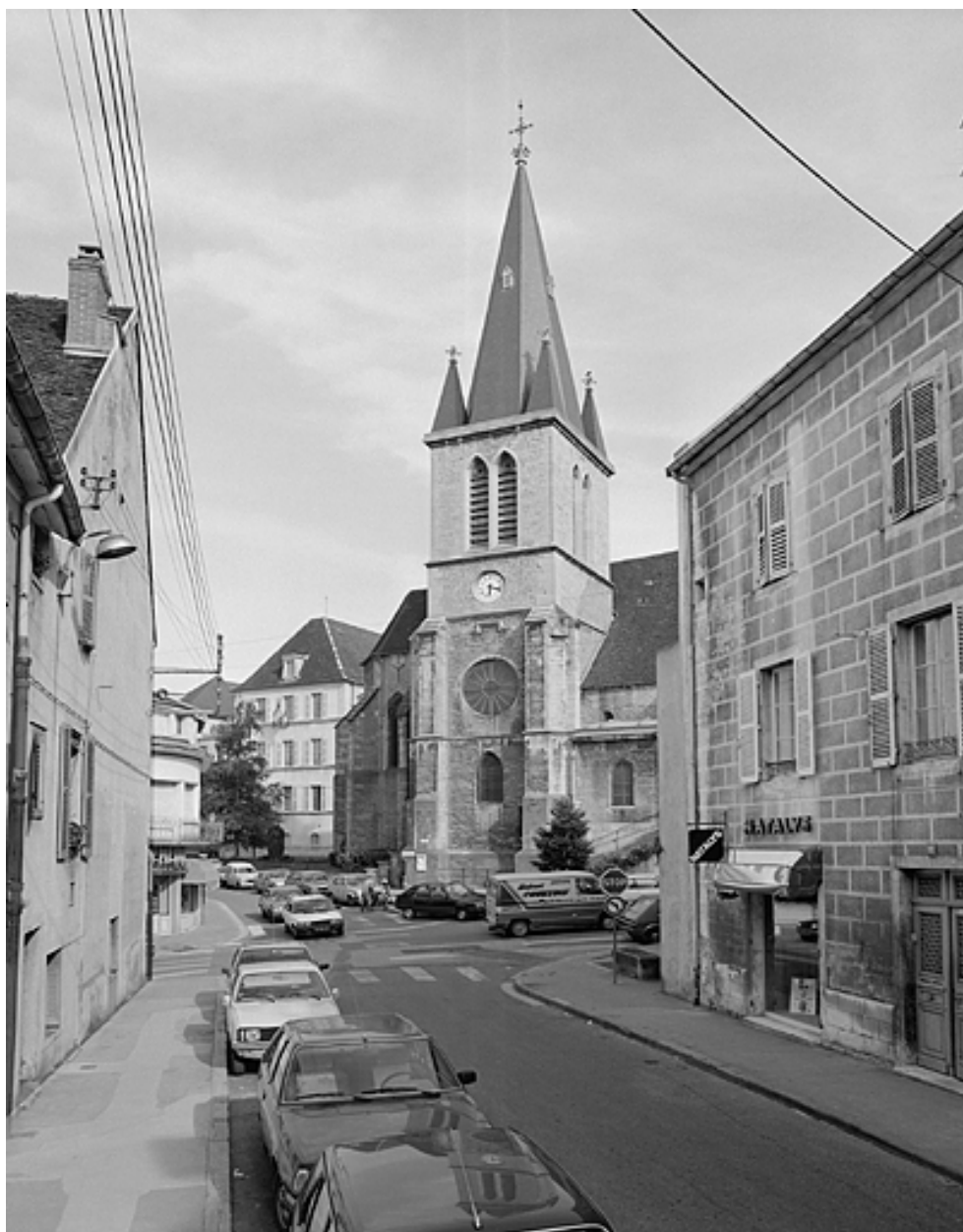
Eglise Saint-Désiré. Vue générale du clocher.
