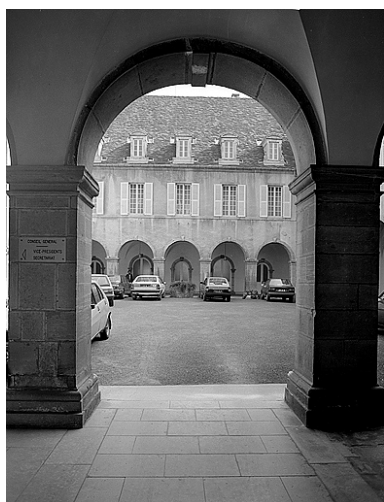
Vue du cloître depuis la galerie ouest. Phot. Yves Sancey IVR43_19833900525X
