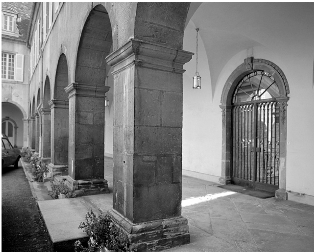
Cloître, galerie sud : porte d'accès à l'escalier.
