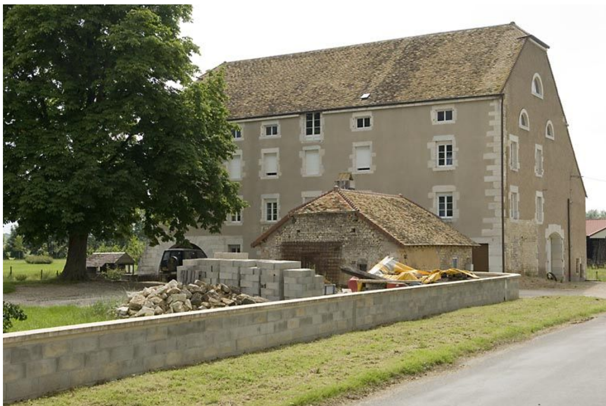
Vue du moulin depuis le nord-est.
