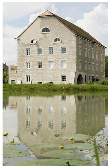
Le moulin vu de trois quarts. Phot. Jérôme Mongreville IVR43_20087000555NUC2A
