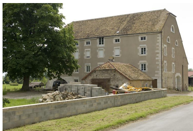
Vue du moulin depuis le nord-est. Phot. Jérôme Mongreville IVR43_20087000556NUC2A
