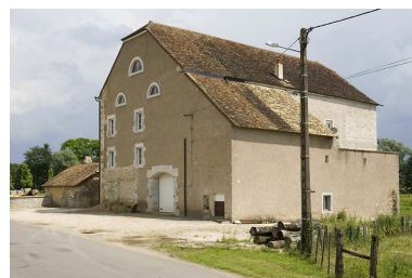
Le moulin vu de trois quarts arrière. Phot. Jérôme Mongreville IVR43_20087000549NUC2A
