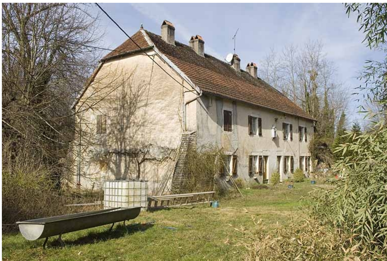
Logement d'ouvriers. Vue de trois quarts.
