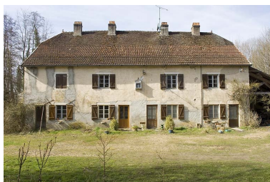
Logement d'ouvriers. Façade antérieure. Phot. Jérôme Mongreville IVR43_20097000164NUC2A
