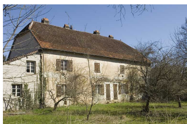
Logement d'ouvriers. Façade postérieure. Phot. Jérôme Mongreville IVR43_20097000174NUC2A
