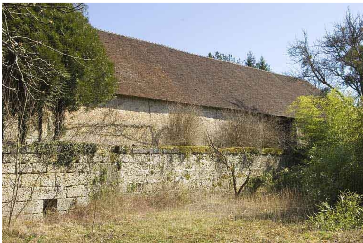
Façade ouest de la halle à charbon.
