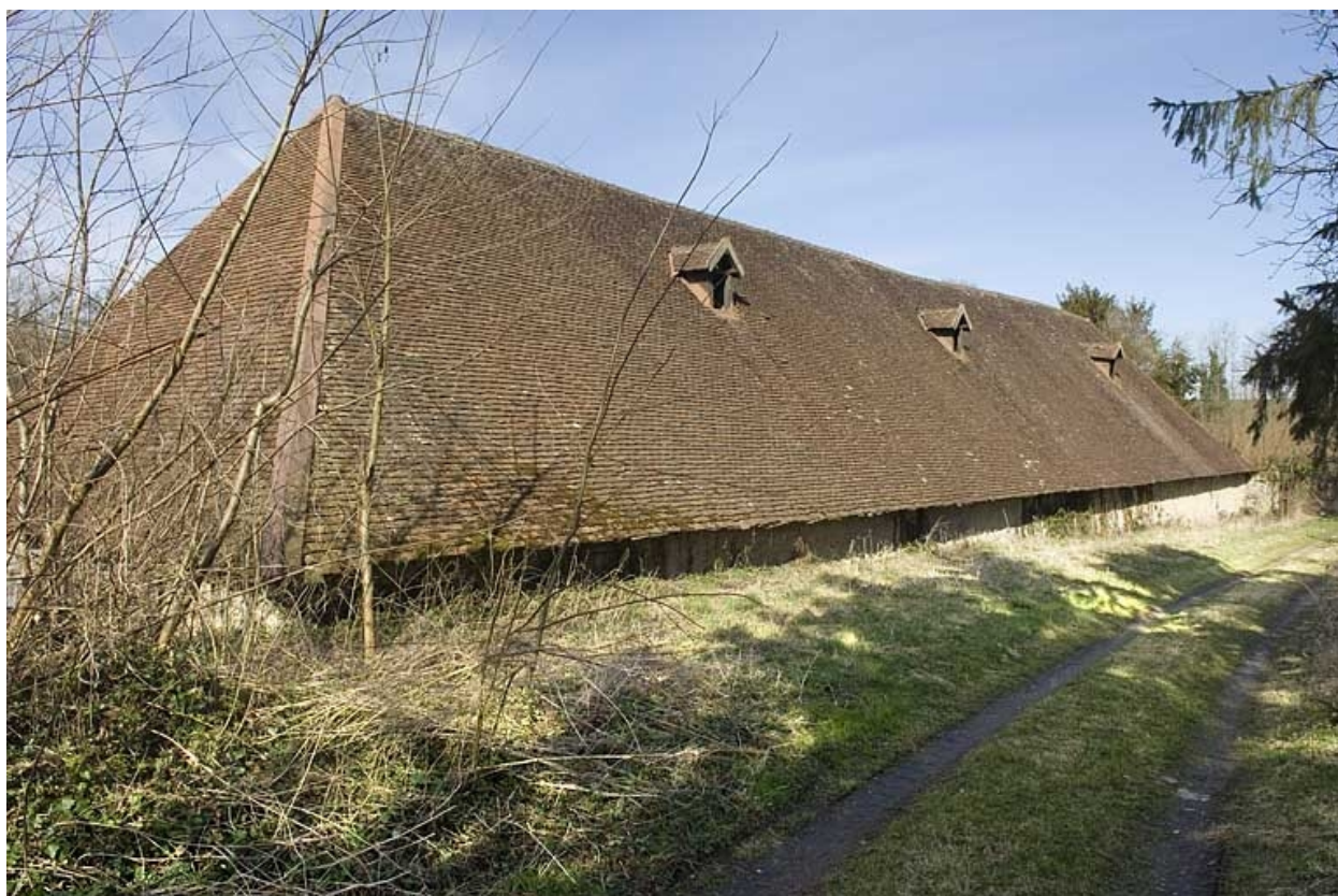
Halle à charbon depuis le sud-est.
