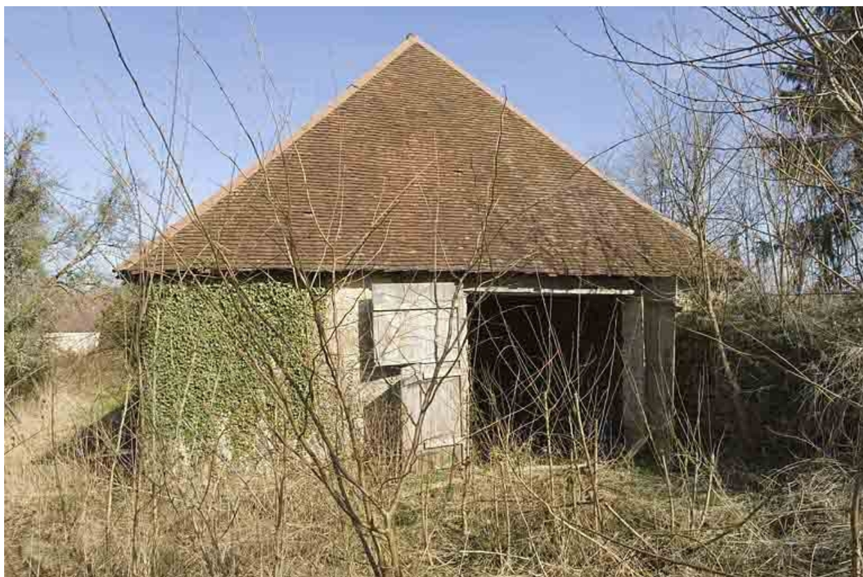
Pignon sud de la halle à charbon.
