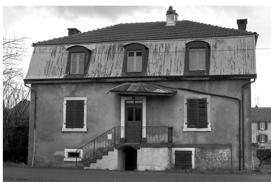
Vue de l'élévation antérieure.
