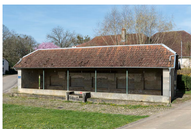
Fontaine-lavoir du Petit- Magny : vue de face depuis l'est. Phot. Sonia Dourlot IVR43_20177000311NUC4A
