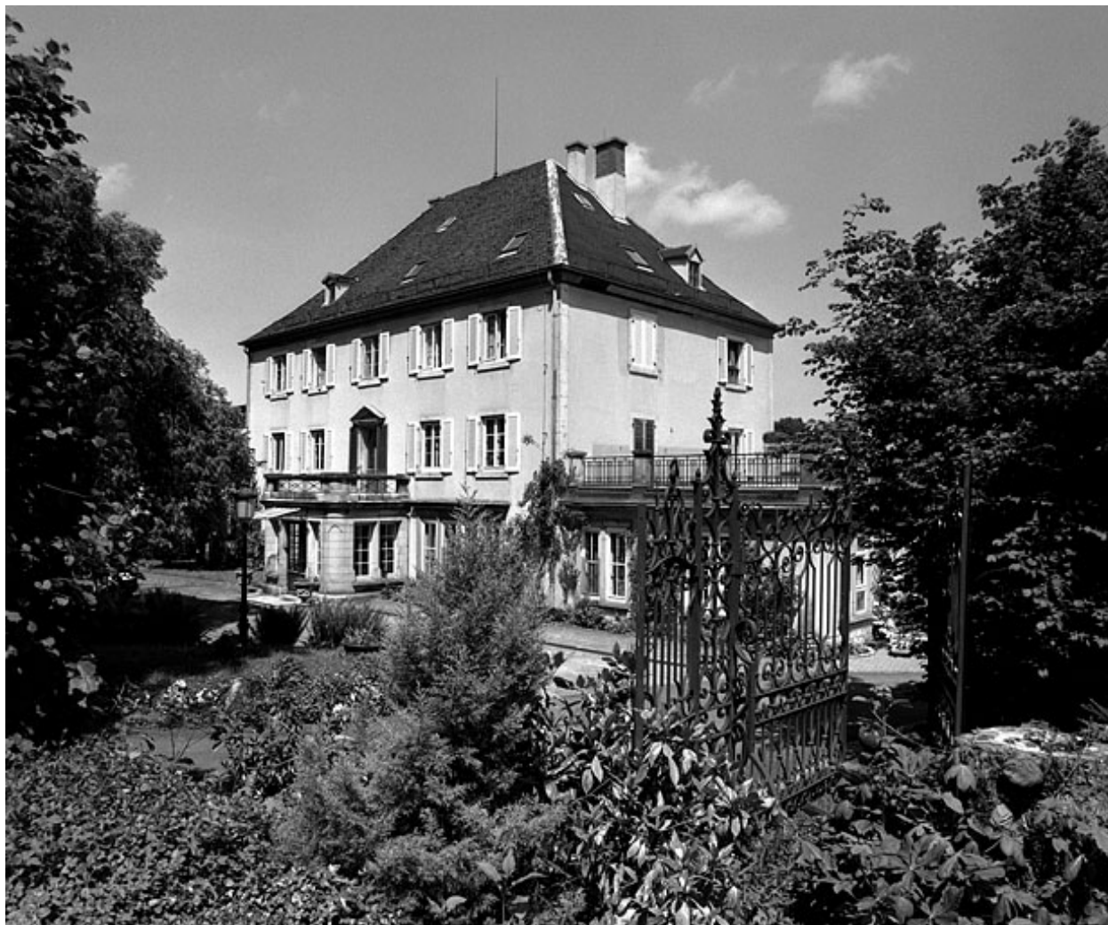
Vue de trois quarts depuis le sud-est.
