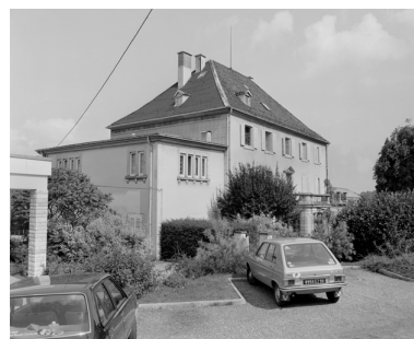
Façade postérieure en 1981.SRI. Enquête régionale sur les bâtiments industriels (1979-1981). Phot. Yves Sancey IVR43_19819000021X
