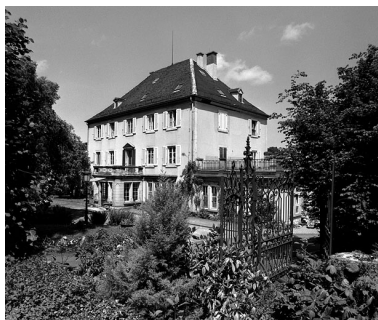
Vue de trois quarts depuis le sud-est.
