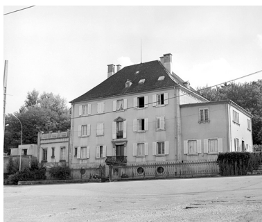
Façade sur rue en 1981.SRI. Enquête régionale sur les bâtiments industriels (1979-1981). Phot. Yves Sancey IVR43_19819000020X
