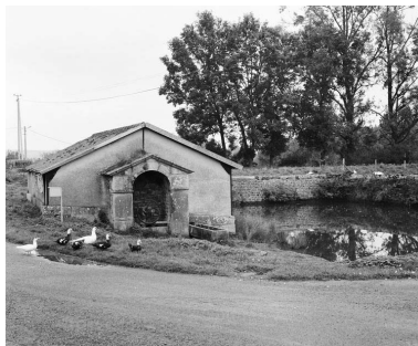
Pignon avec fontaine. Phot. Michel Thierry IVR26_19812101845X
