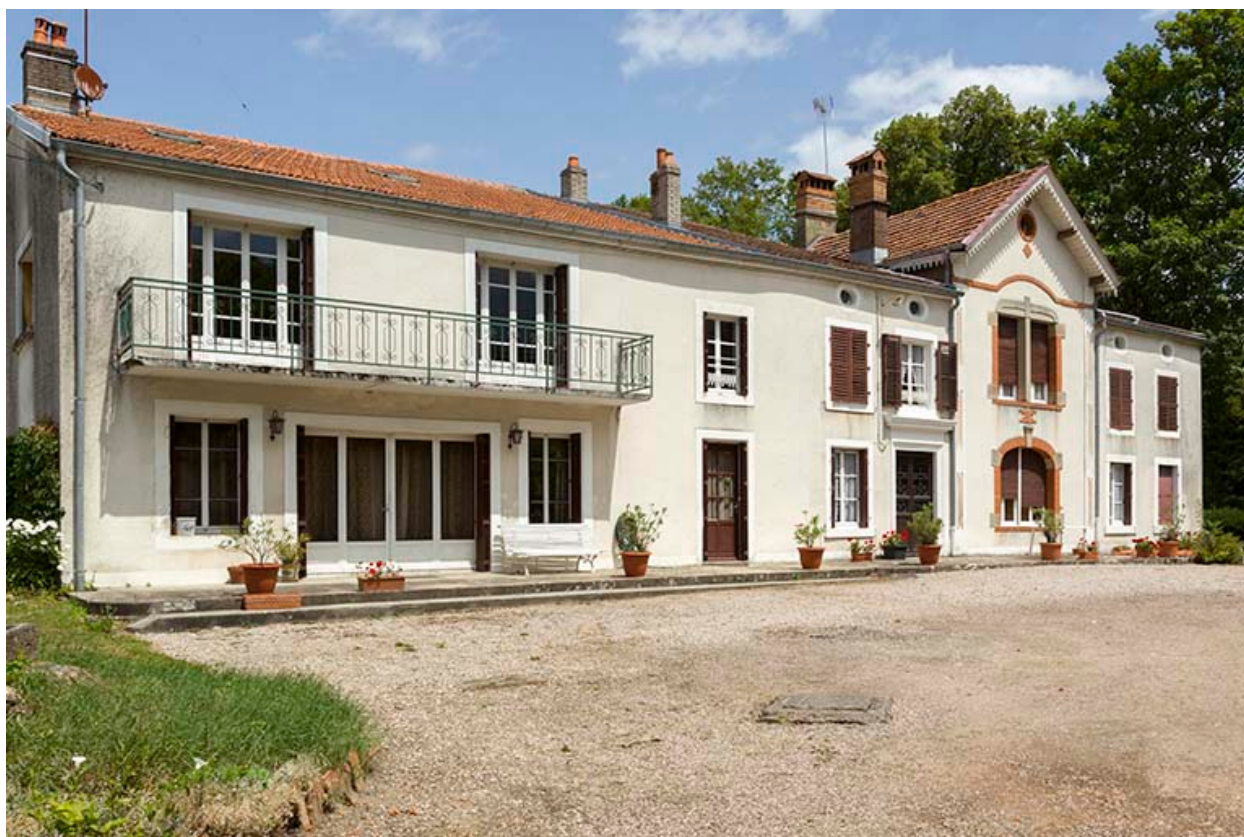
Maison "Boileau", ancien directeur de la verrerie.
