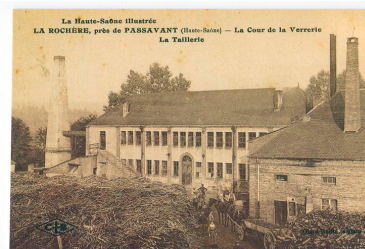
La verrerie, carte postale. Phot. Guillaume Gézolme, Autr. auteur inconnu IVR43_20167000065NUC4A
