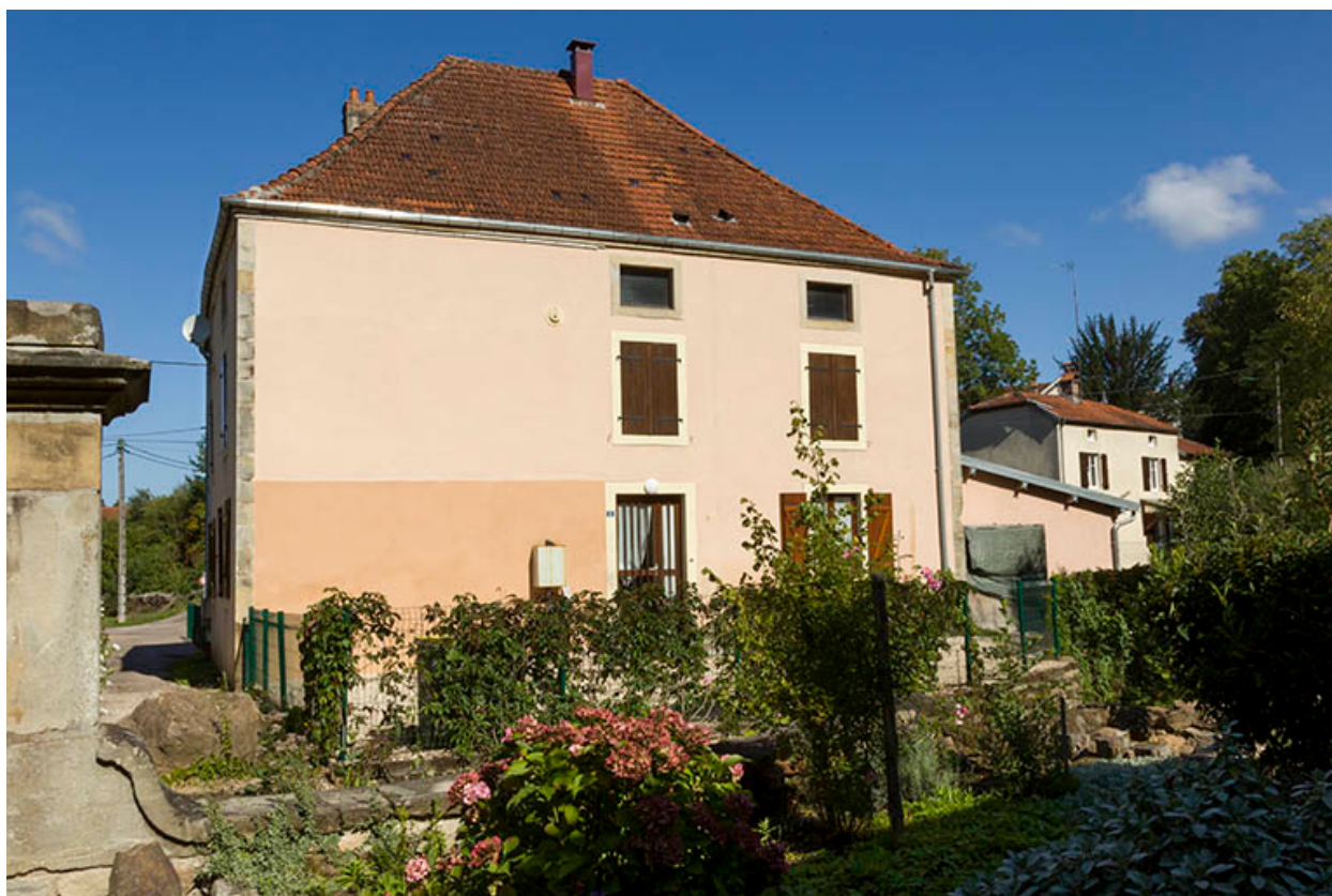
Maison, façade postérieure, rue du Moulin.
