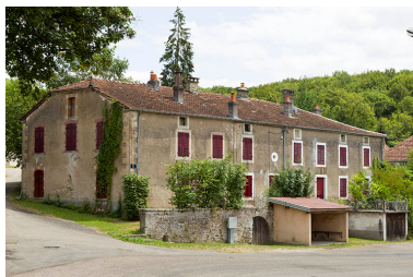
Logements d'ouvriers, place Dieu. Phot. Sonia Dourlot IVR43_20157000714NUC2A
