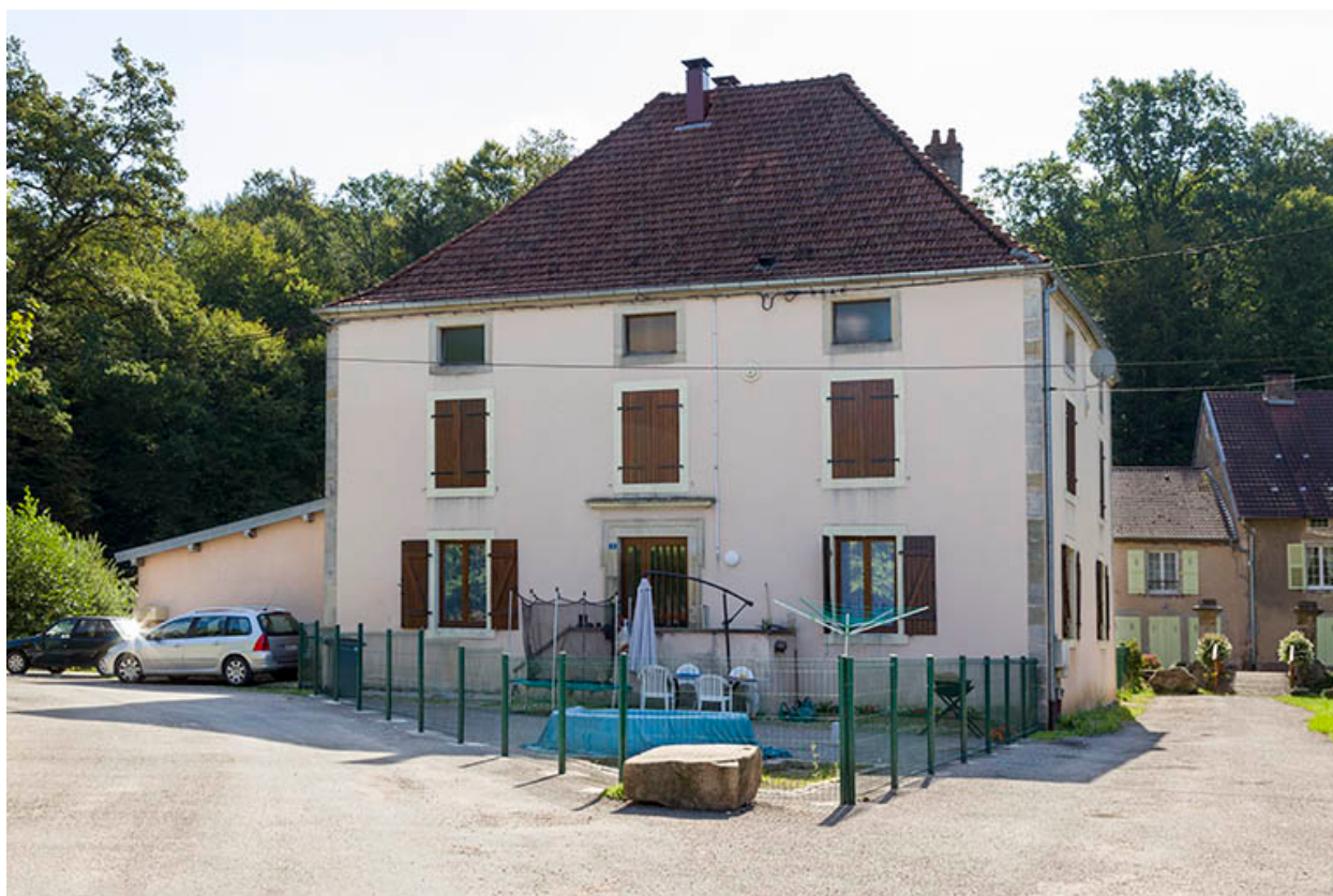
Maison, rue du Moulin.
