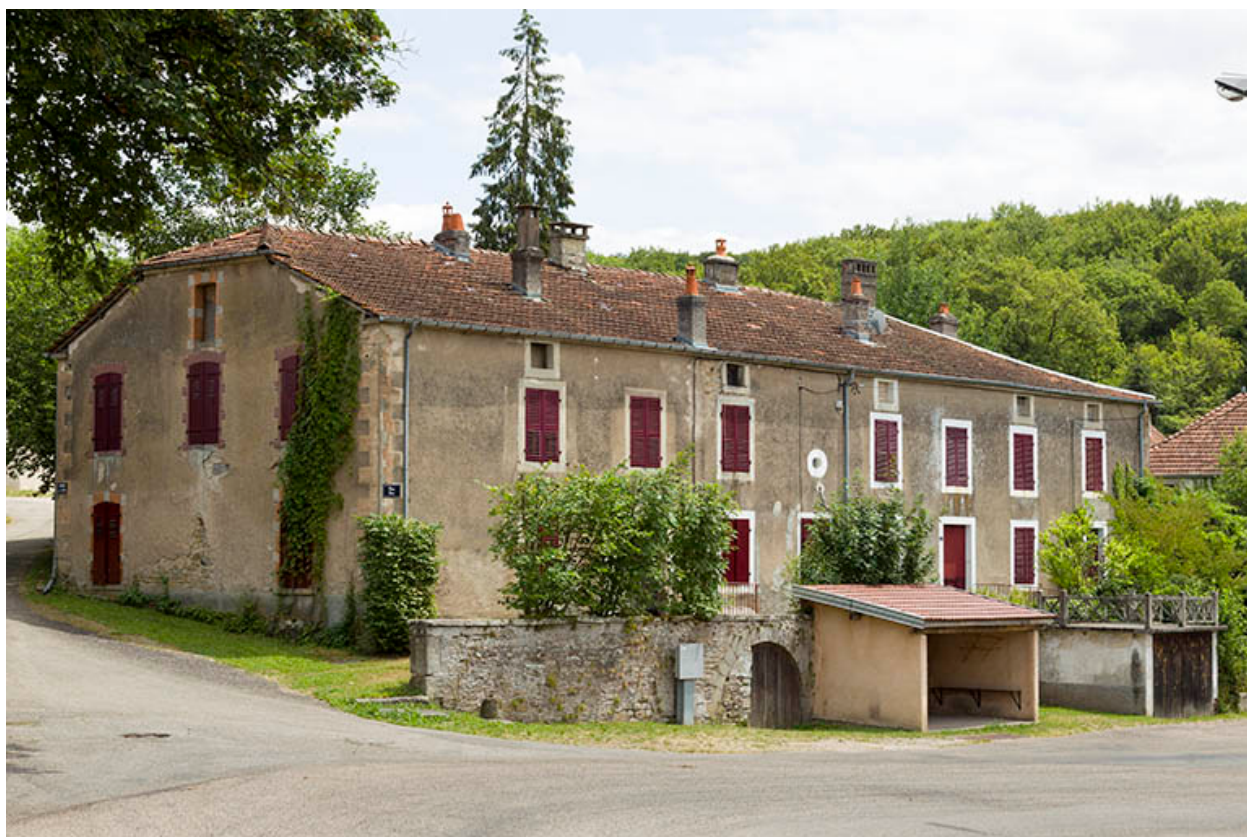
Logements d'ouvriers, place Dieu.
