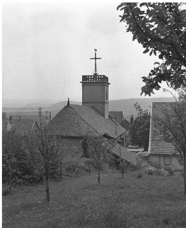
Extérieur : abside, vue de trois quarts. Phot. Yves Sancey IVR43_19763900159X
