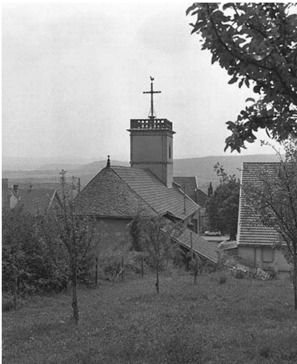
Extérieur : abside, vue de trois quarts.
