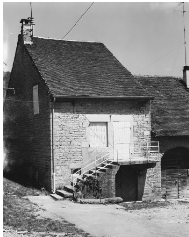
Façade antérieure. Phot. Dominique Dominguez IVR43_19803900242X
