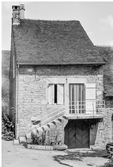
Façade antérieure. Phot. Bernard Pontefract IVR43_19763900292Z
