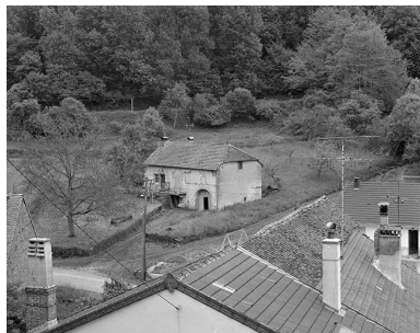
Vue de situation. Phot. Yves Sancey IVR43_19813900112X
