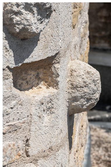
Détail du bossage à la tour des Cordeliers (plateforme). Phot. Thierry Kuntz IVR26_20242100380NUC4A
