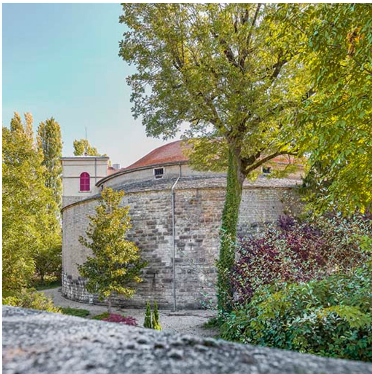
La tour des Filles.
