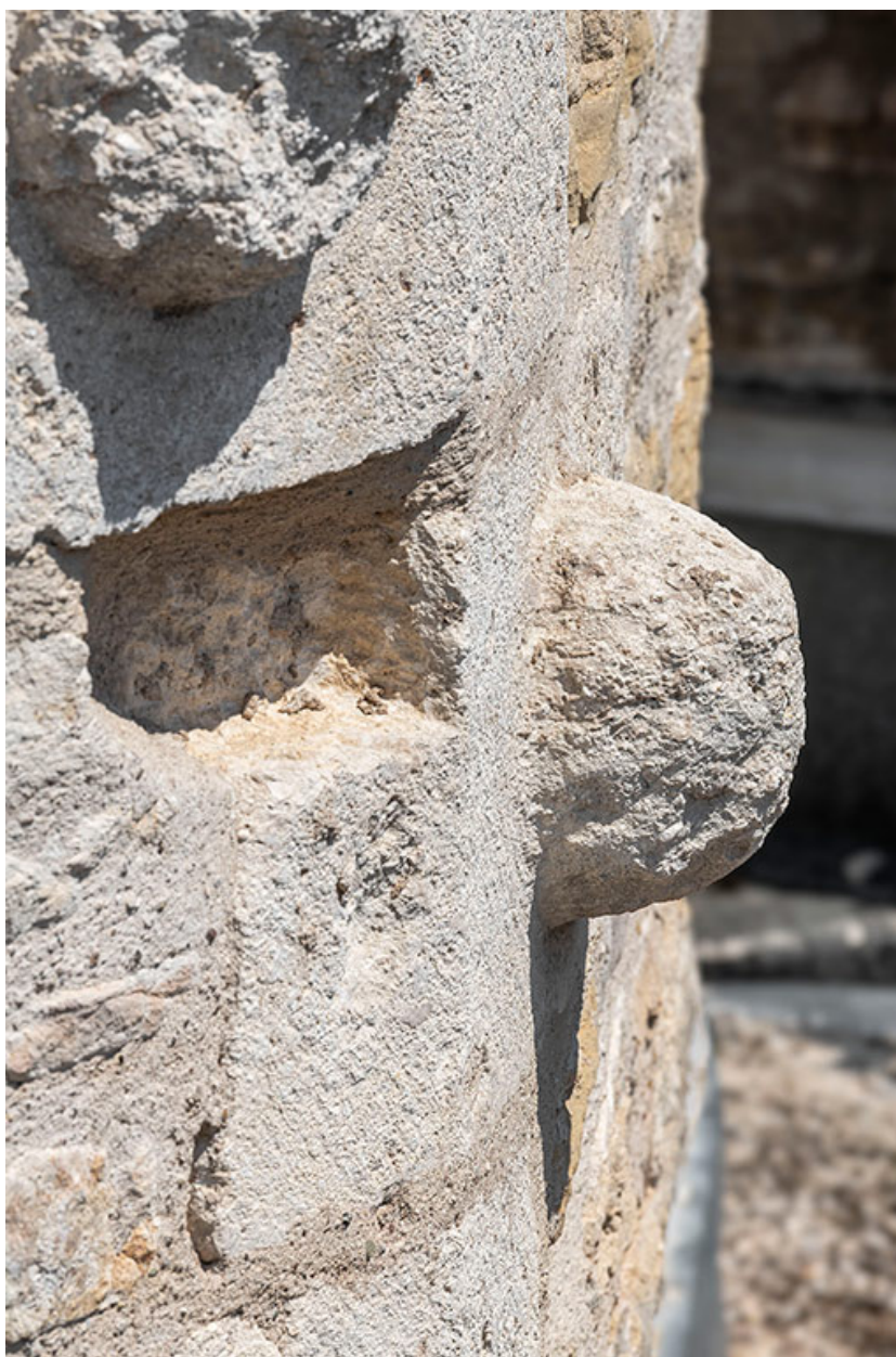
Détail du bossage à la tour des Cordeliers (plateforme).
