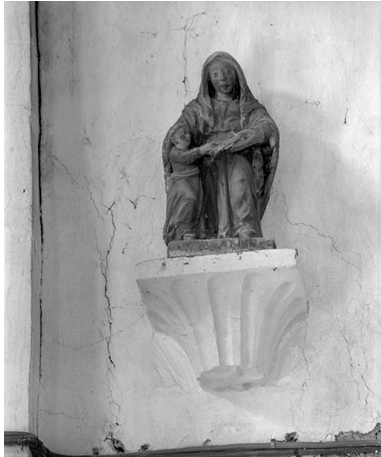
Vue d'ensemble : face. Phot. Michel Thierry IVR26_19748900464X
