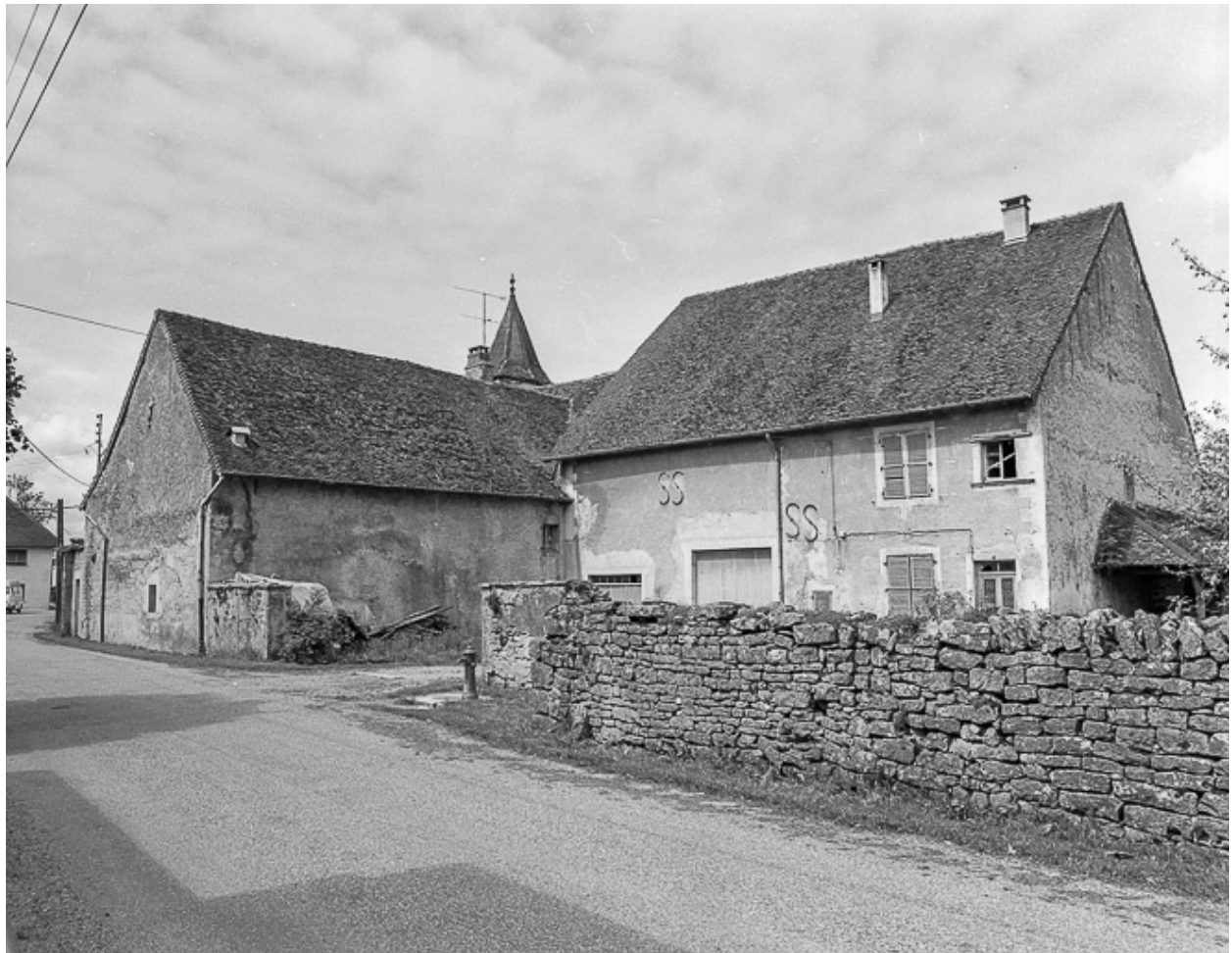
Bâtiments donnant sur la rue.
