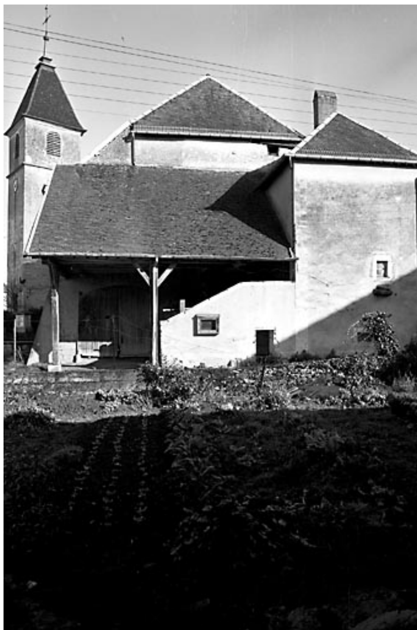
Ferme située 2 rue du Château.
