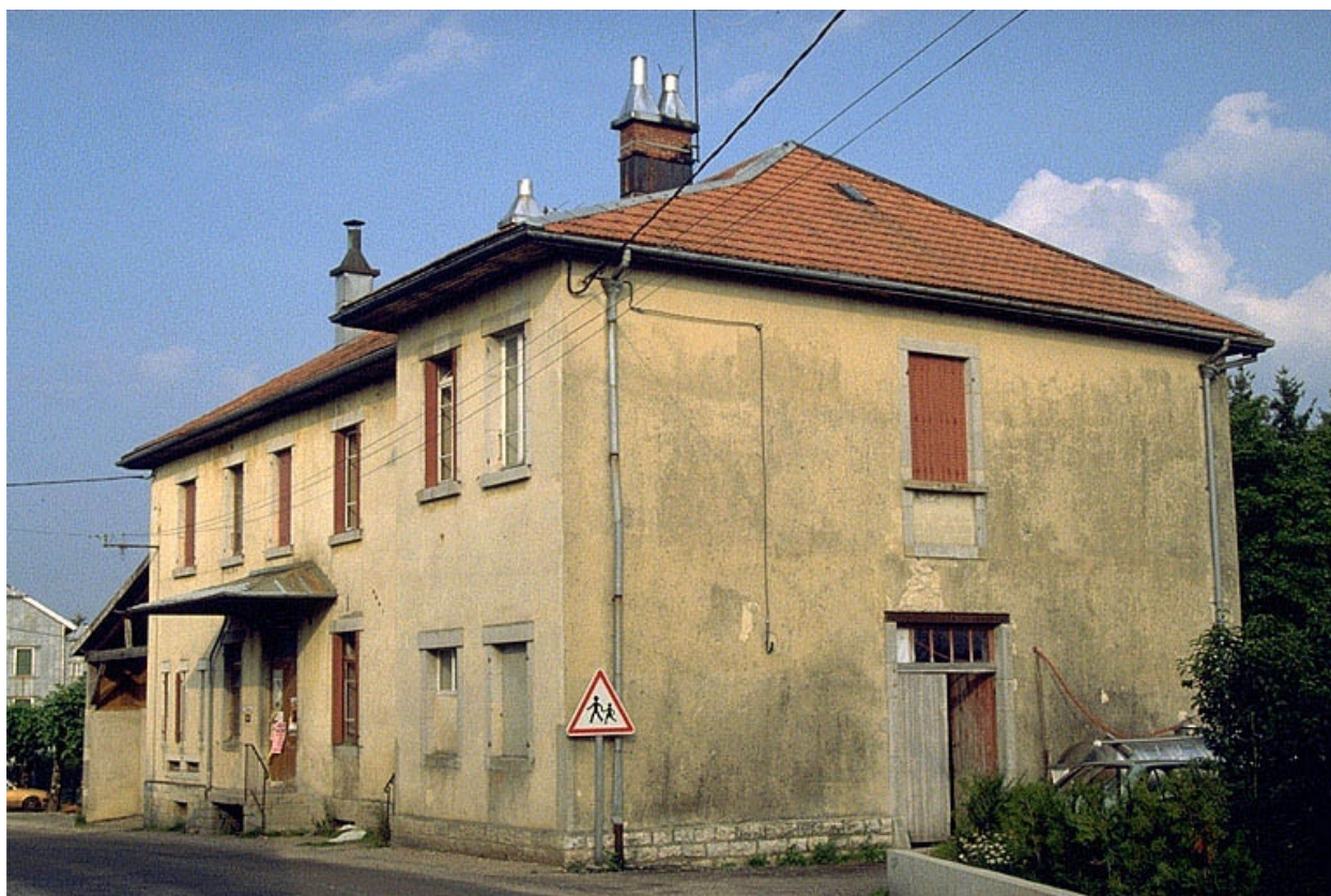
Façades antérieure et latérale droite.
