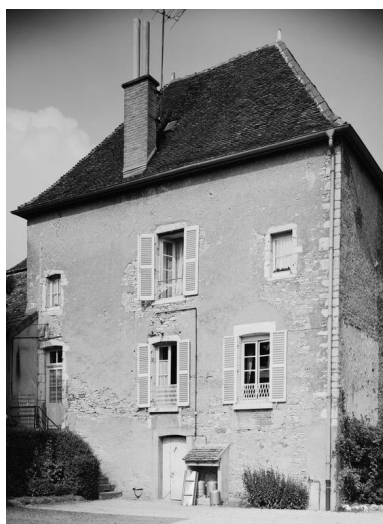
Elévation postérieure de la maison sise parcelle 123, section D1 sur le cadastre de 1967. Phot. Michel Thierry IVR26_19792101432V
