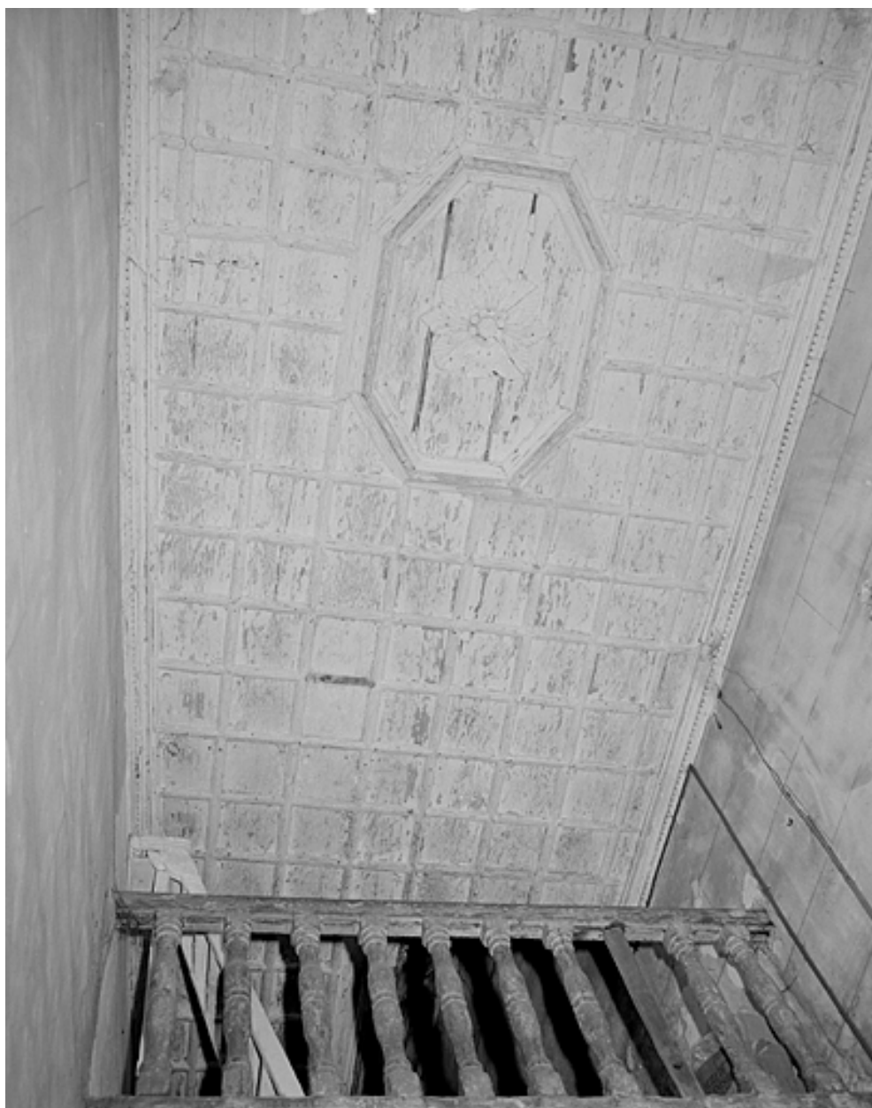
Escalier, plafond à caissons.
