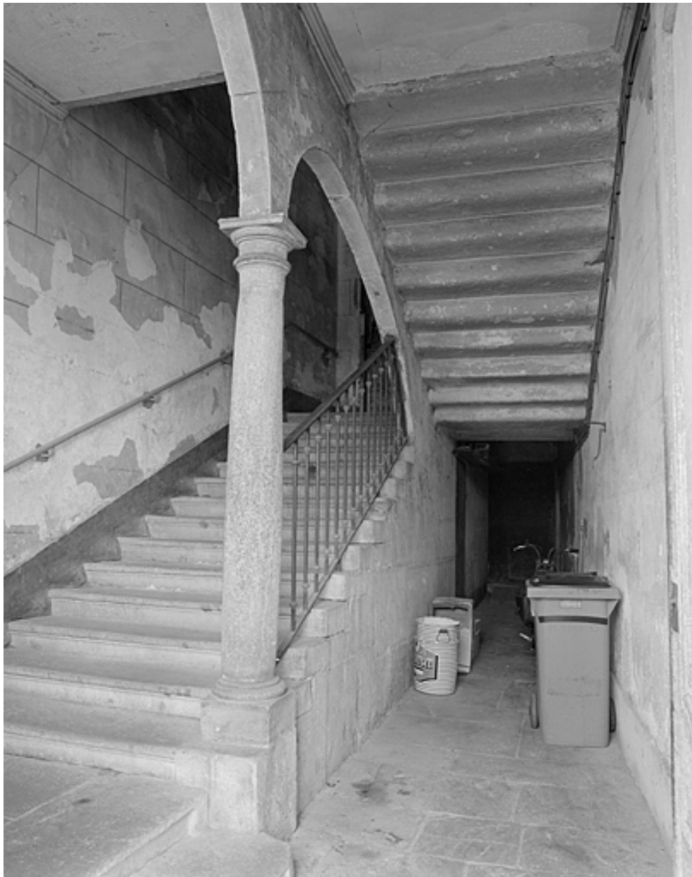
Vue de l'escalier depuis le vestibule.
