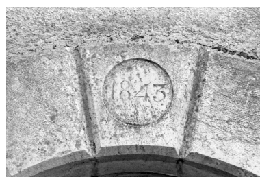
Porte centrale de la minoterie : date portée. Phot. Laurent Poupard IVR43_19883900655Z
