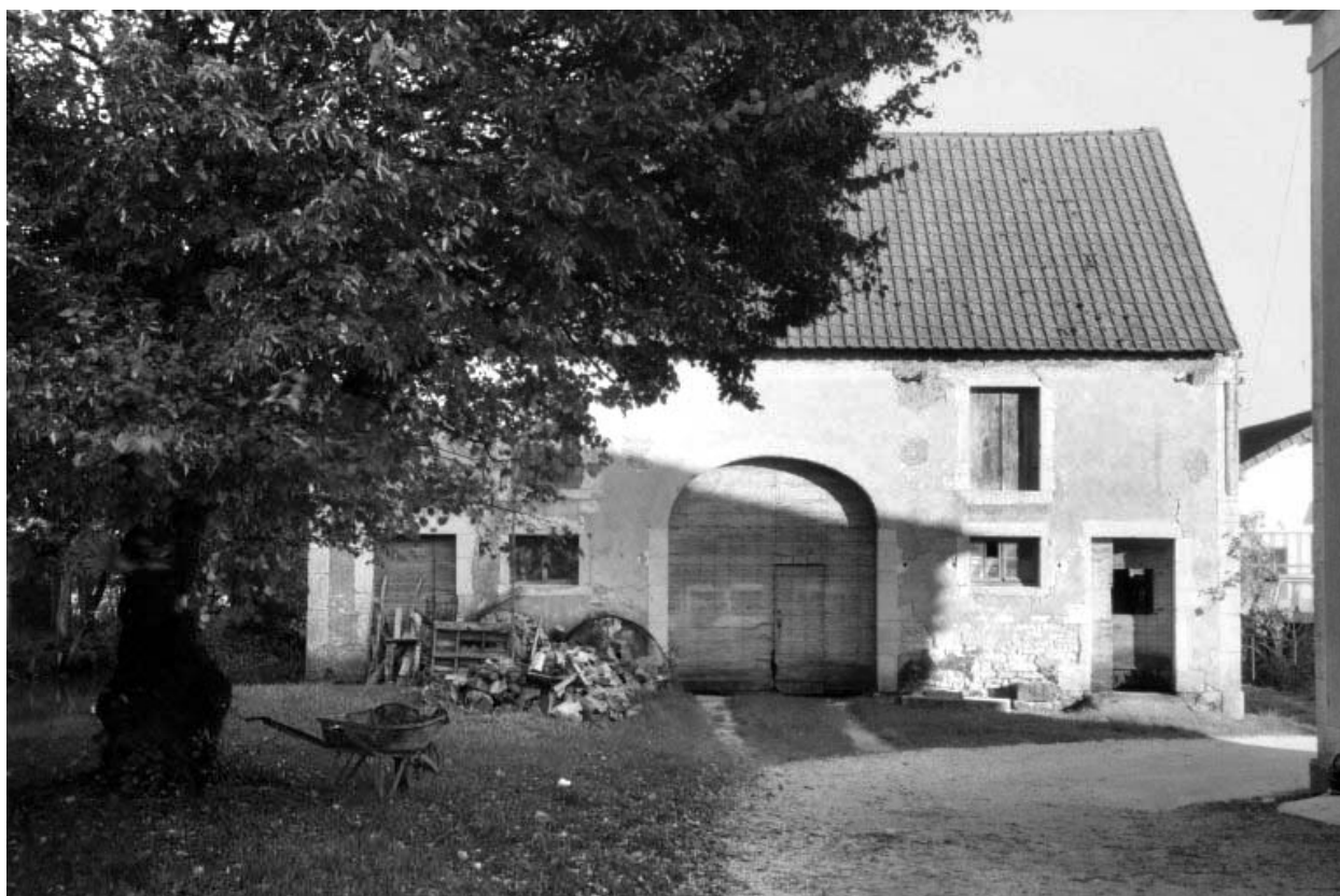
Façade antérieure de l'ancien battoir (D).
