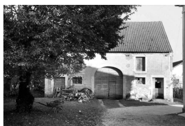
Façade antérieure de l'ancien battoir (D). Phot. Laurent Poupard IVR43_19883900654Z
