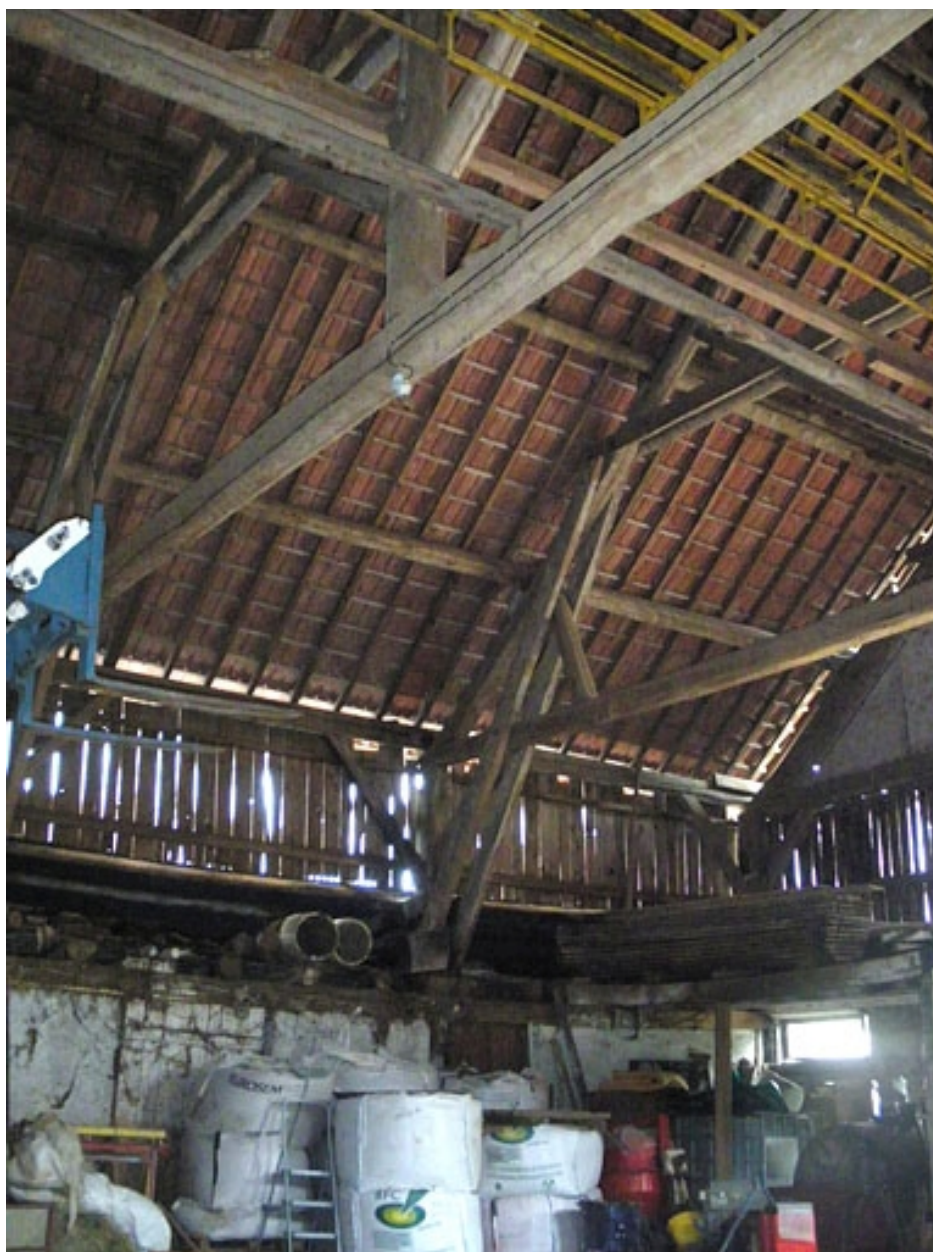
Remise agricole : charpente.
