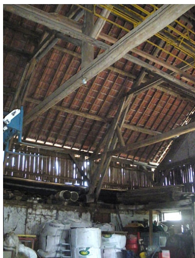
Remise agricole : charpente.
