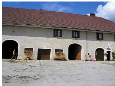
Vue latérale de la façade antérieure.
