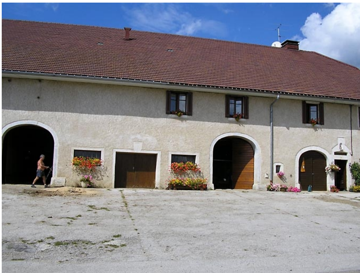
Vue latérale de la façade antérieure.
