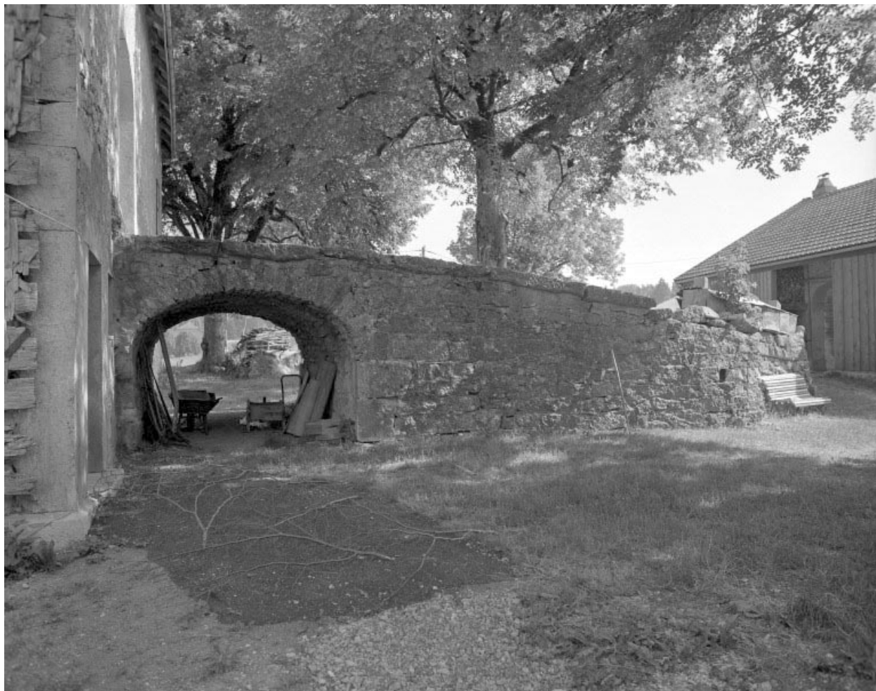
Pont de grange vu sur le côté.
