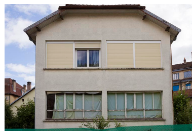
Façade latérale gauche. Phot. Yves Sancey IVR43_20132501790NUC2A
