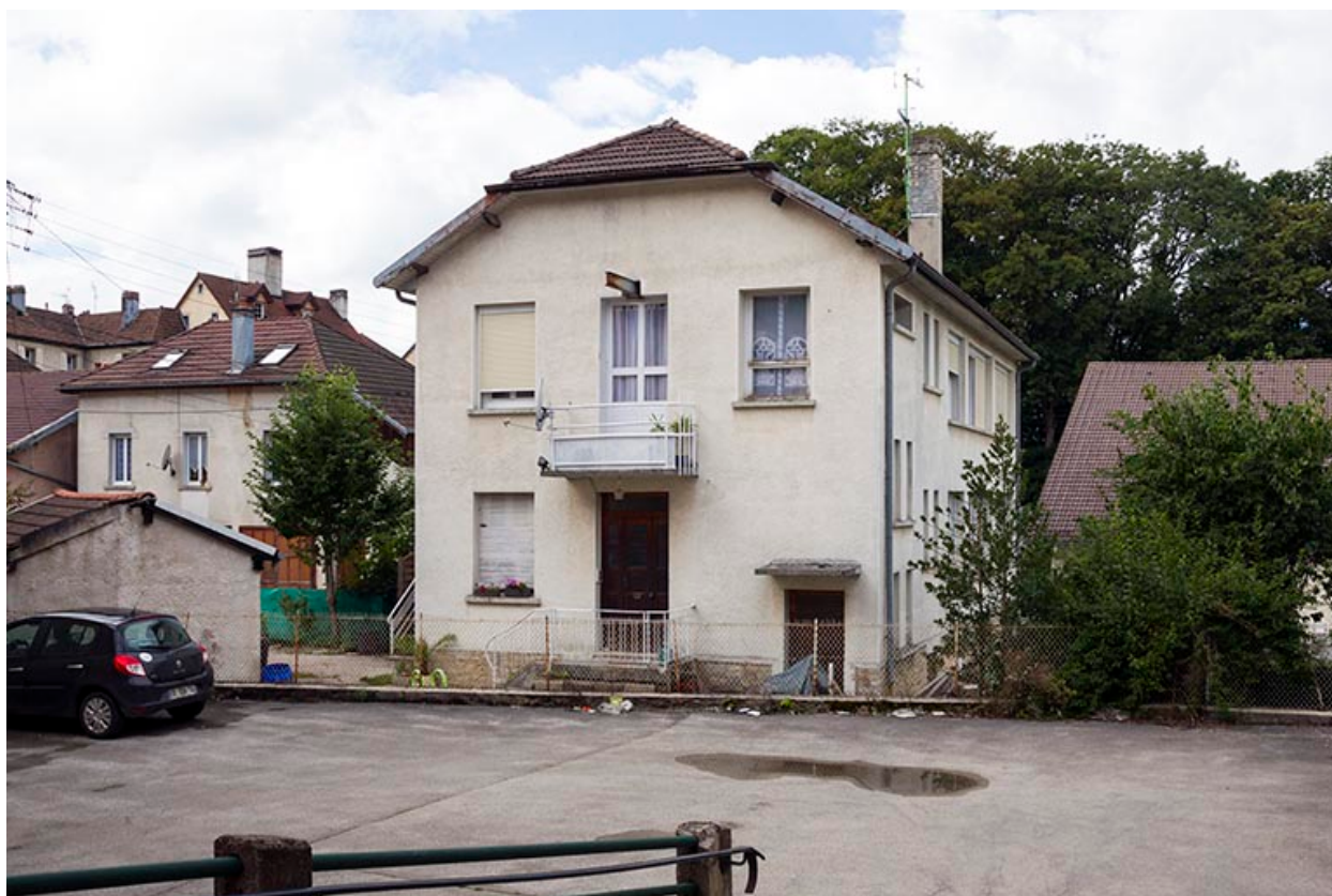
Façade latérale droite.
