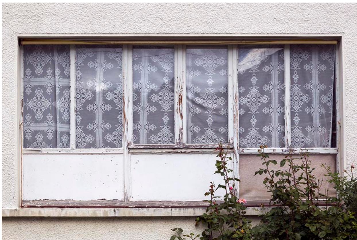
Façade antérieure : fenêtre d'atelier au rez-de-chaussée.
