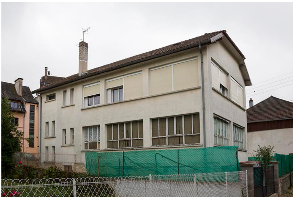
Façades postérieure et latérale gauche.
