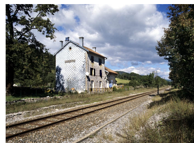
Vue d'ensemble, depuis le sud (façade postérieure). Phot. Yves Sancey IVR43_20043900360XA
