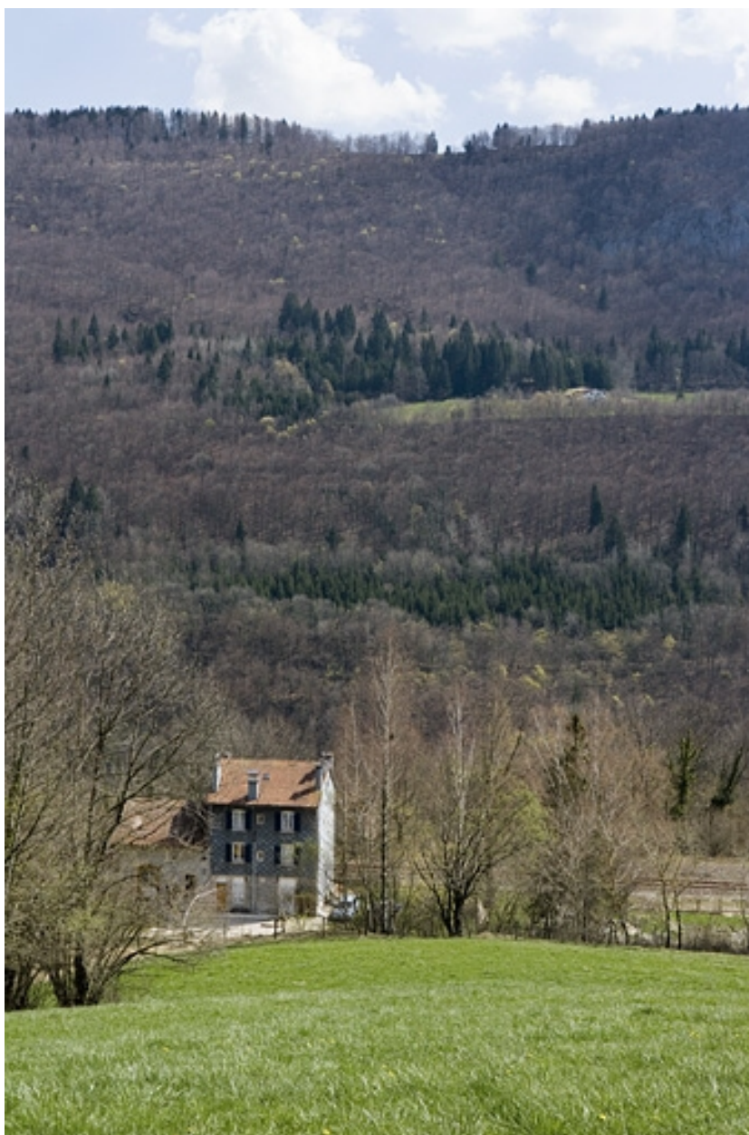
Vue d'ensemble du site, depuis le nord-ouest.
