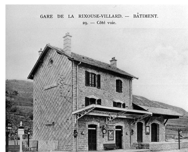
Bâtiment. - Côté voie, [1919]. Phot. Jérôme Mongreville IVR43_20003900833X
