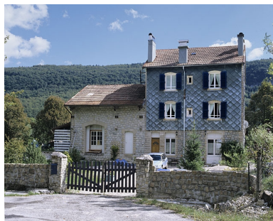
Façade antérieure. Phot. Yves Sancey IVR43_20043900358XA
