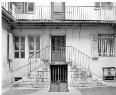
Façade postérieure : rez-de-chaussée surélevé et escalier extérieur. Phot. Yves Sancey IVR43_20033900807X
