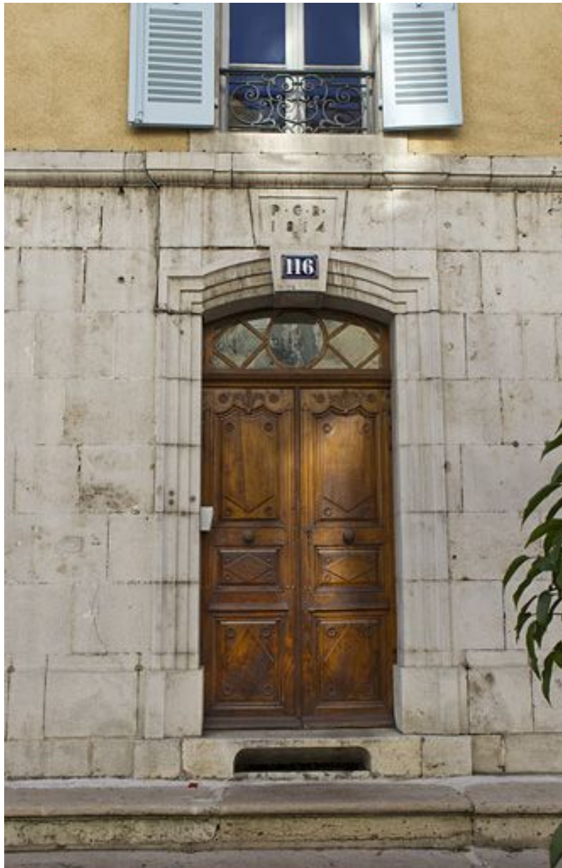
Façade antérieure : porte principale.
