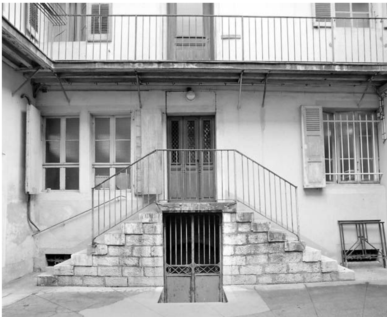
Façade postérieure : rez-de-chaussée surélevé et escalier extérieur.
