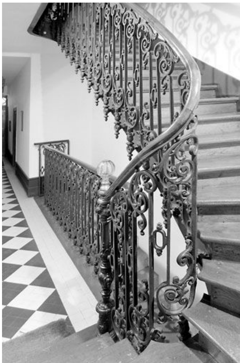
Escalier tournant, depuis l'extrémité du couloir.
