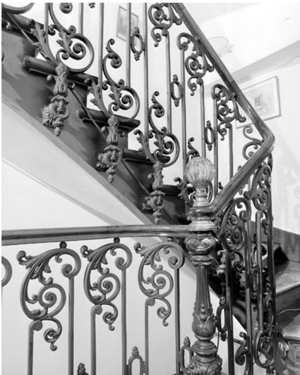
Escalier tournant : détail du garde-corps.
