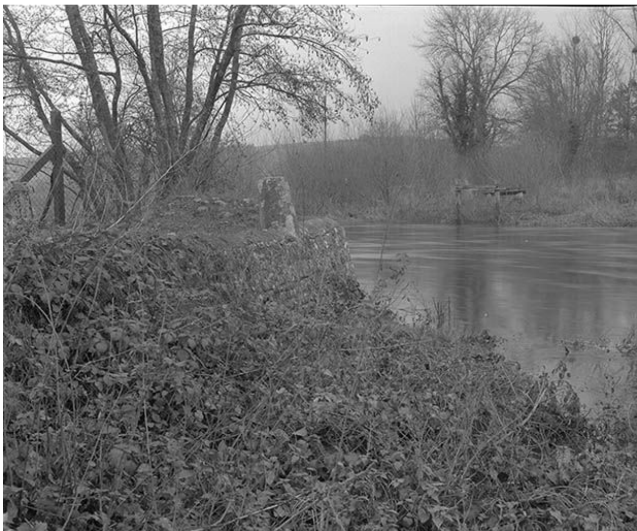
Vestiges de la passerelle. La culée ouest.
