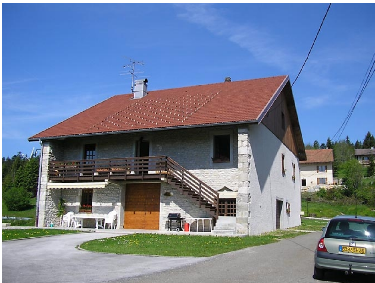
Façade postérieure et pignon sud-ouest.
