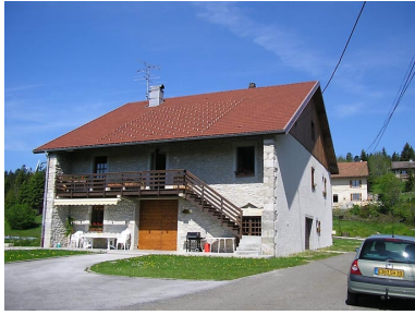
Façade postérieure et pignon sud-ouest. Phot. Marie-Pierre Reynet IVR43_20083900305NUC1A
