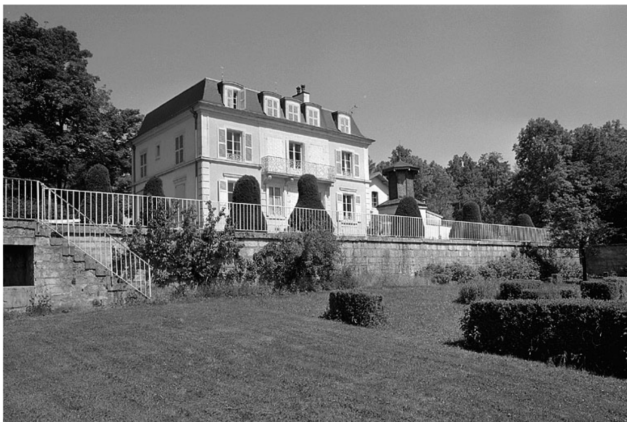
Demeure de notable dite le Château
