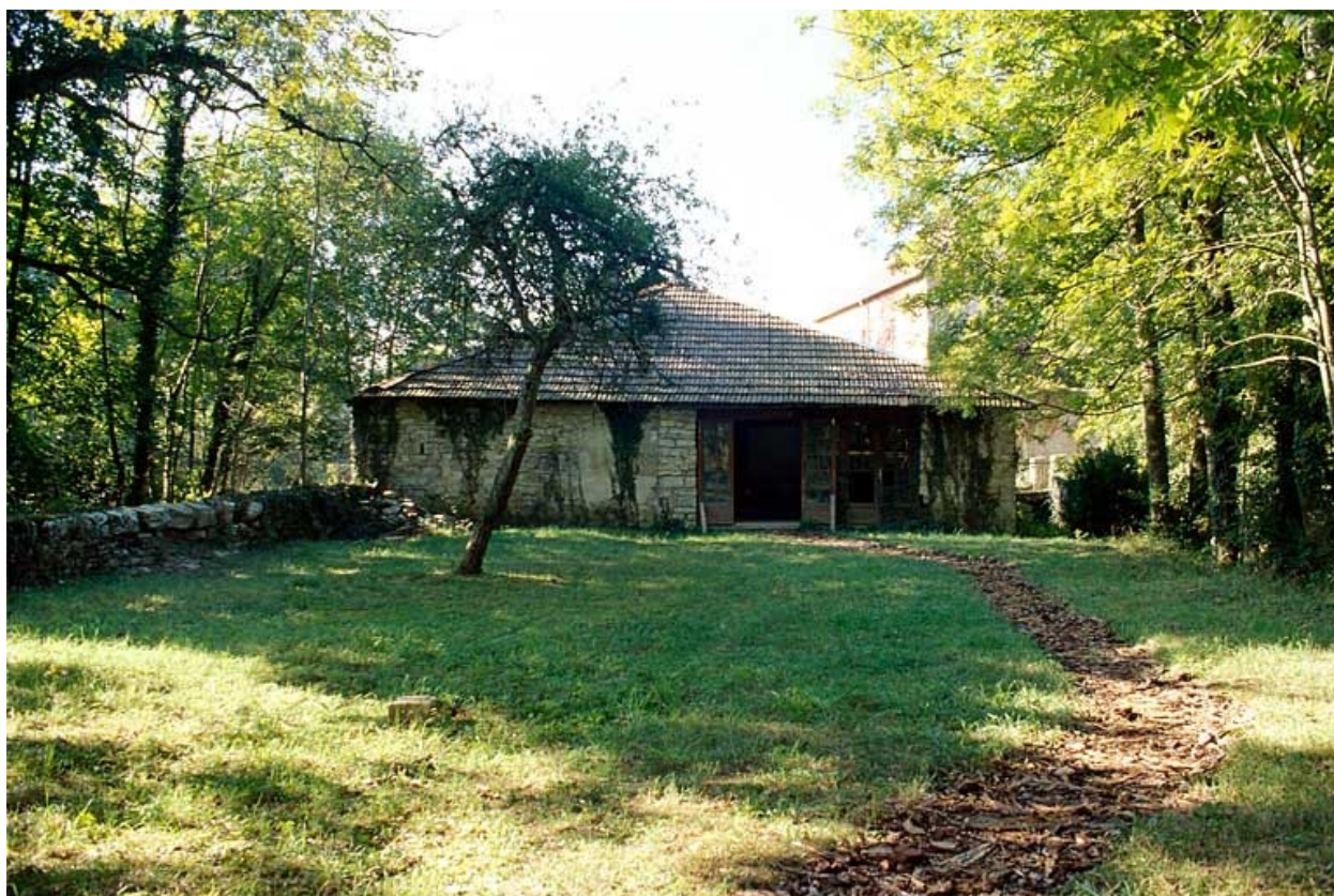
Extrémité ouest de l'atelier de la forge.
