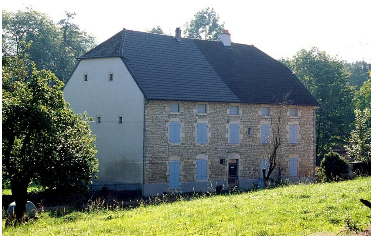
Logement patronal depuis le nord-ouest.
