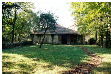
Extrémité ouest de l'atelier de la forge. Phot. Yves Sancey IVR43_19973901060ZA
