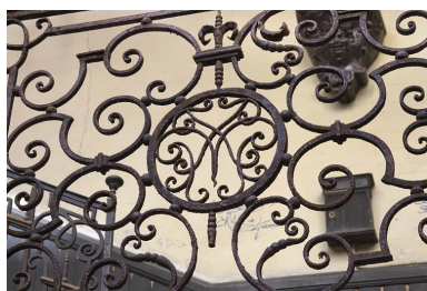
Première cour : détail de la feronnerie de l'escalier à cage ouverte ornée d'un monogramme.
