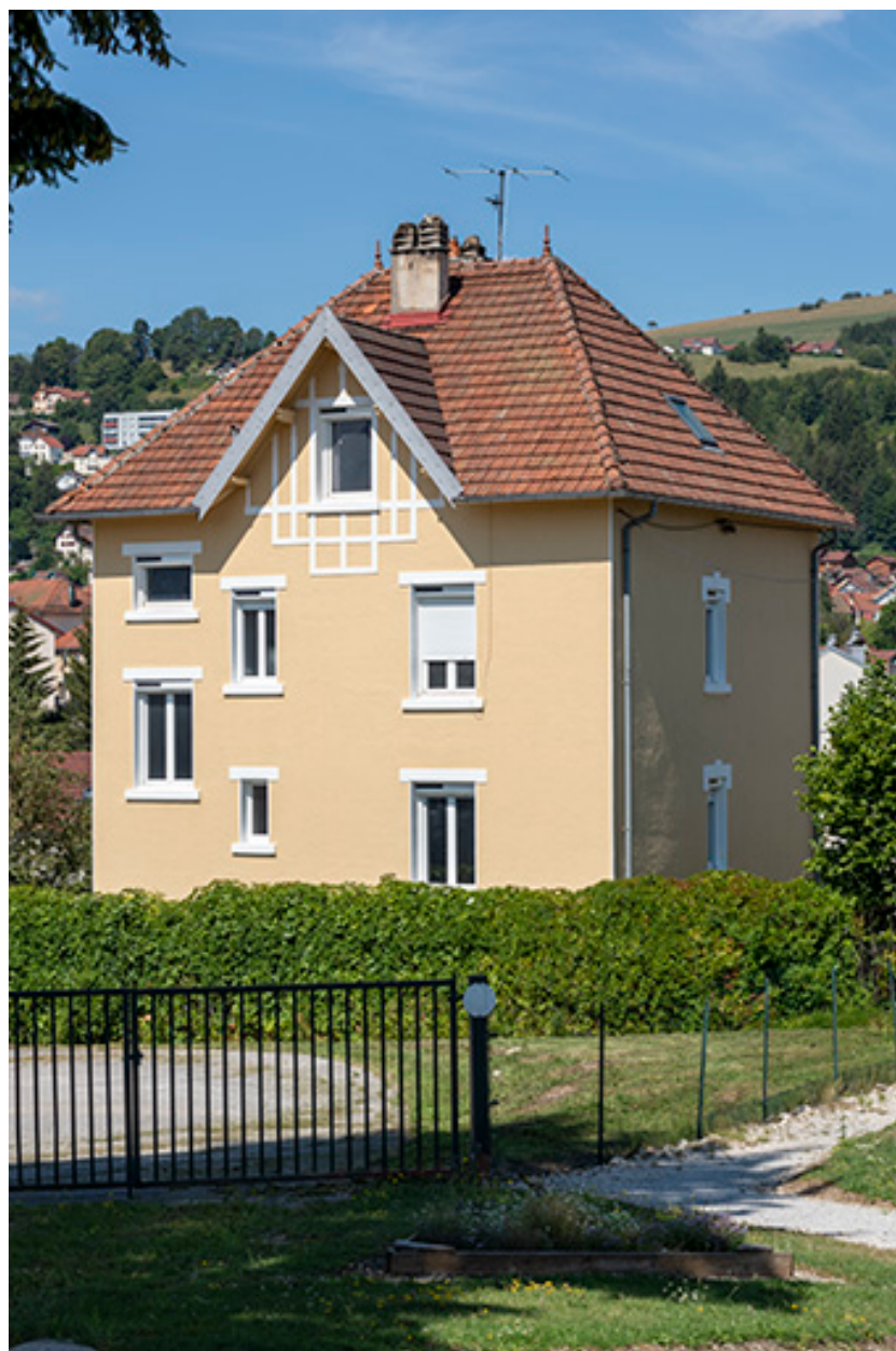
Façades postérieure et latérale gauche.
