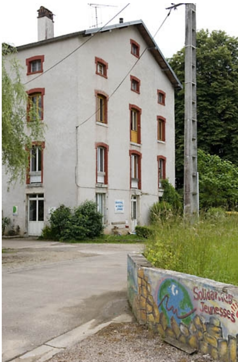
Elévation occidentale de l'atelier de fabrication.
