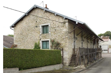
Façade sur rue du logement ouvrier. Phot. Jérôme Mongreville IVR43_20087000524NUC2A
