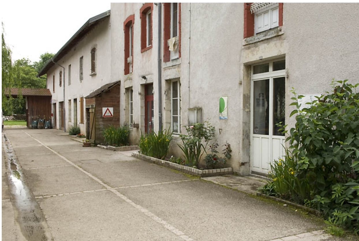
Façade nord vue de trois quarts droite.
