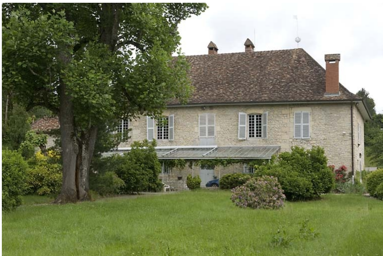
Façade antérieure du logement patronal.
