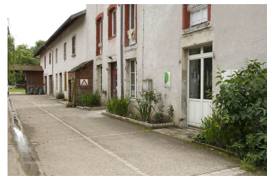
Façade nord vue de trois quarts droite. Phot. Jérôme Mongreville IVR43_20087000531NUC2A
