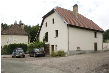
Dépendance du logement patronal. Phot. Jérôme Mongreville IVR43_20087000528NUC2A
