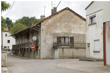
Logement ouvrier vu depuis le sud. Phot. Jérôme Mongreville IVR43_20087000530NUC2A
