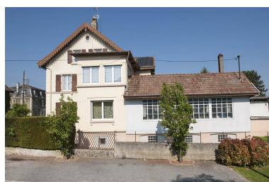
Pignon et façade sud de l'atelier. Phot. Jérôme Mongreville IVR43_20112501416NUC4A
