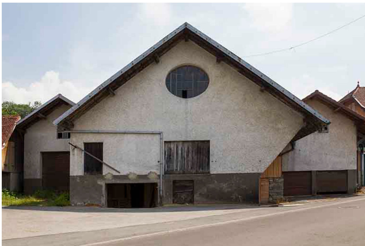
Atelier de fabrication et stockage de sicure.
