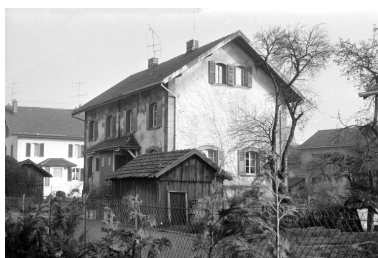
Façades antérieure et latérale droite.
