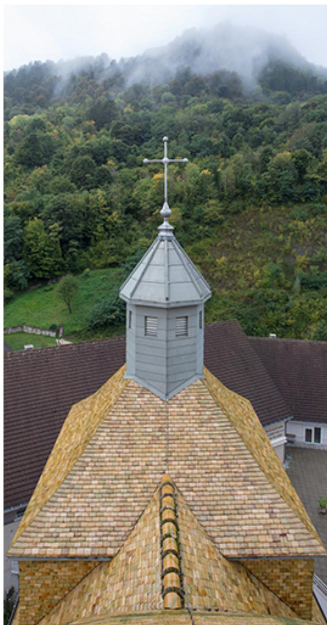
Toiture de la sacristie, depuis le lanterneau.
