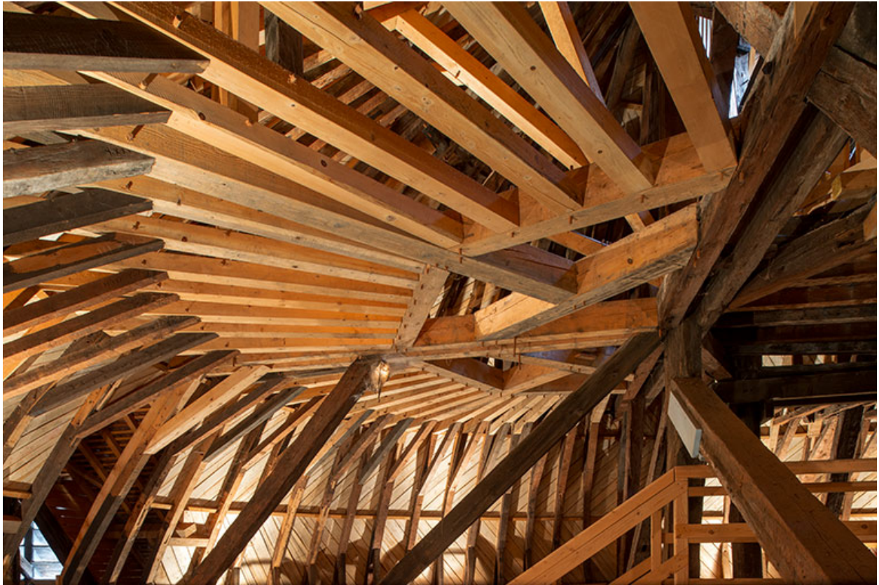
Enrayure du côté occidentale, depuis le sud.
