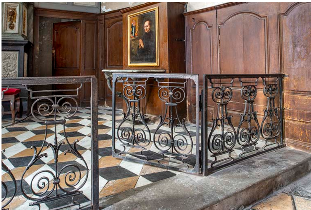
Clôture en ferronnerie du chœur.
