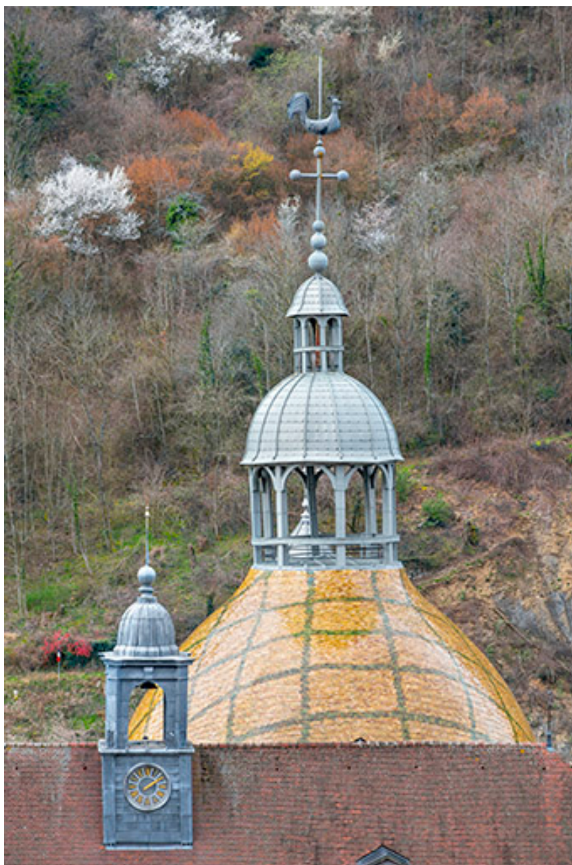
Vue de la coupole depuis l'est.
