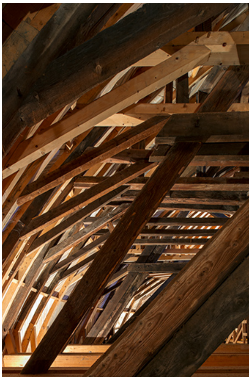
Côté sud de la charpente du dôme.
