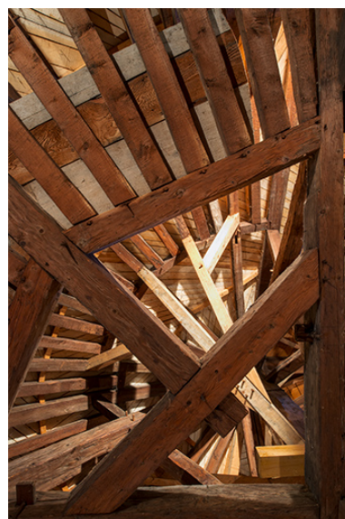
Enrayure nord-est de la charpente du dôme. Phot. Nicolas Waltefaugle IVR43_20253900346NUC4A
