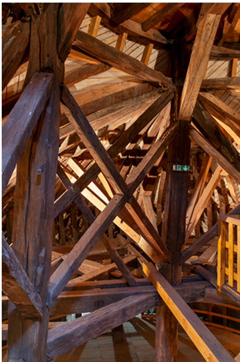
Entretoise du niveau intermédiaire, côté nord.
