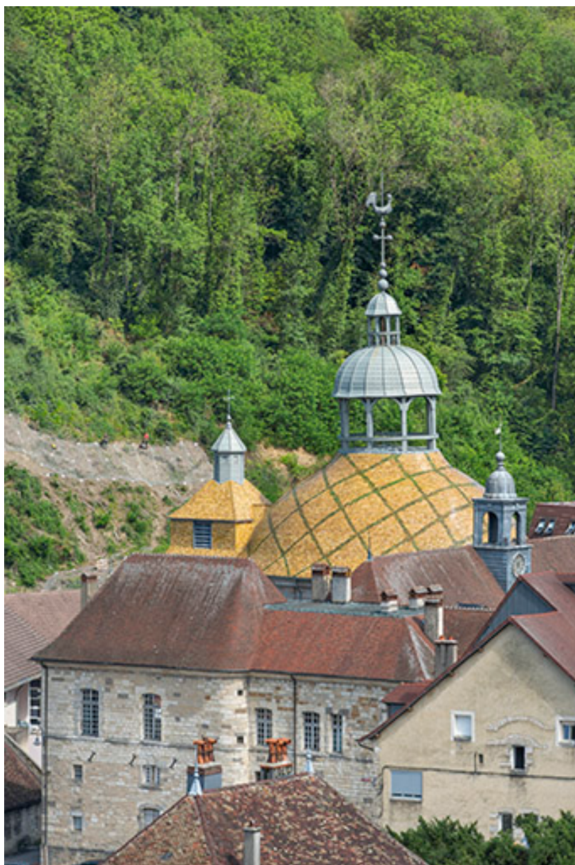
Vue plongeante depuis le sud-est.
