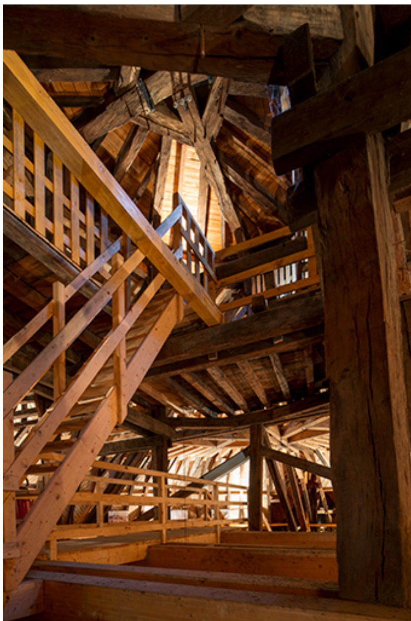
Beffroi du dôme, en contre-plongée, depuis l'est.
