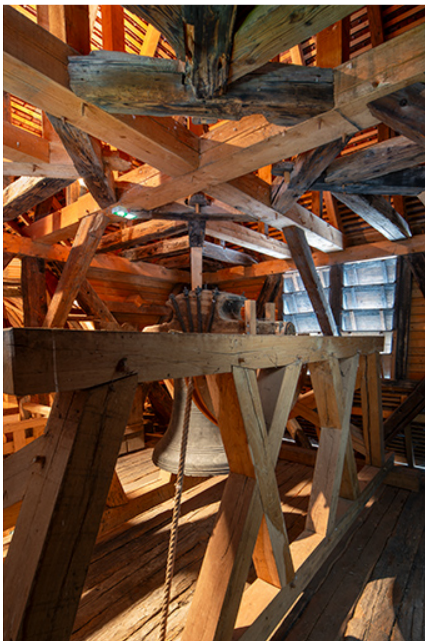
Campanile de la sacristie. Charpente du beffroi.
