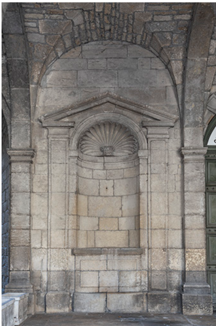
Façade antérieure du parvis. Niche sud.
