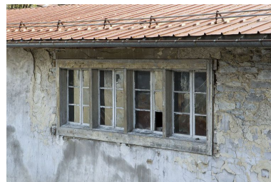
Fenêtres lunetières de l'aile sud. Phot. Yves Sancey IVR43_20103900168NUC2A
