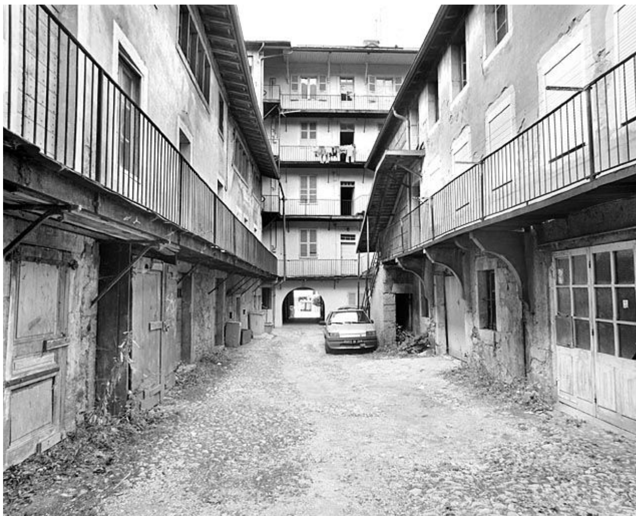
Cour et élévation postérieure.
