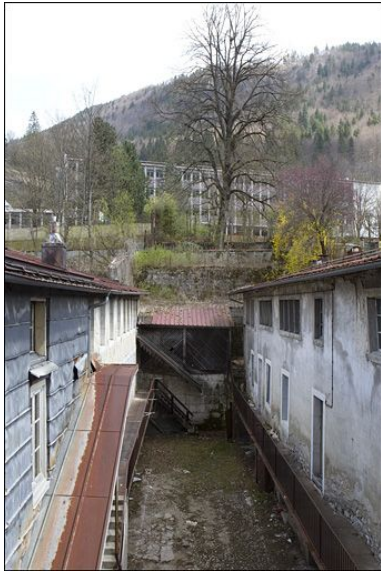
Immeuble avec atelier (18 e siècle) au n° 161 rue de la République : murs de soutènement des jardins.
