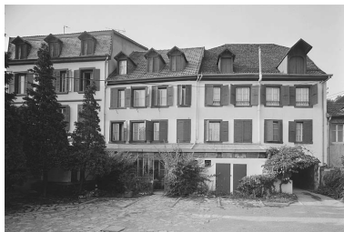
Façades sur jardin. Phot. Jérôme Mongreville IVR43_19872501083V
