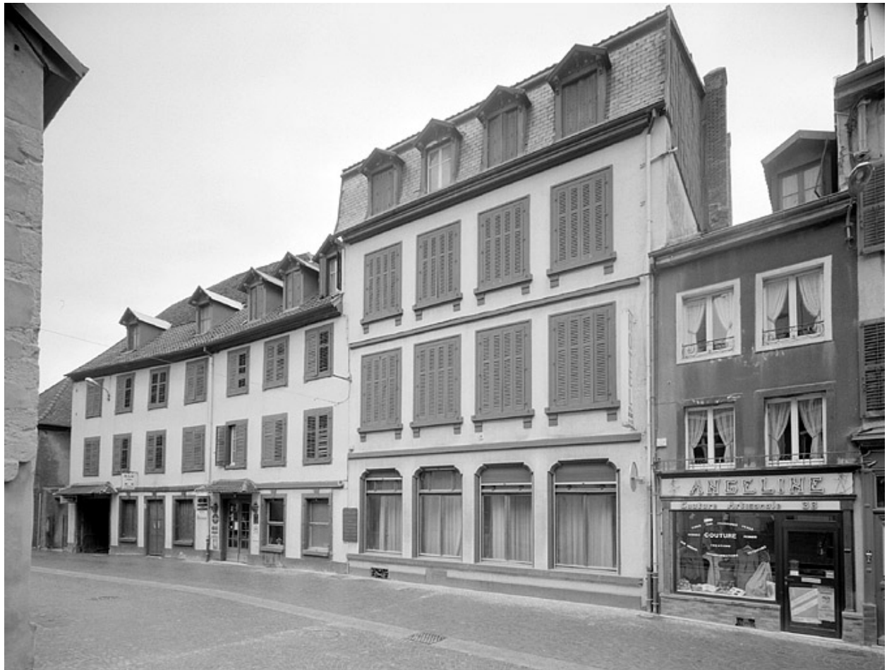
Façades sur rue.
