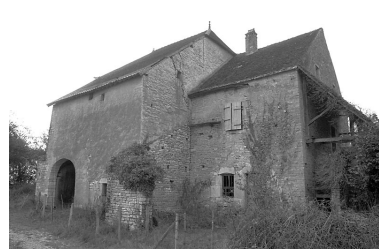
Ferme située impasse des Champs du Four. Phot. Bernard Lardière IVR43_19797000047Z
