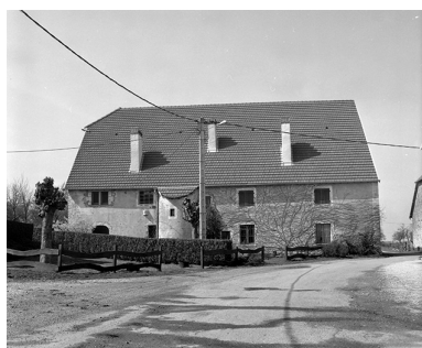
Ferme située place de la Mairie. Phot. Yves Sancey IVR43_19827000475X
