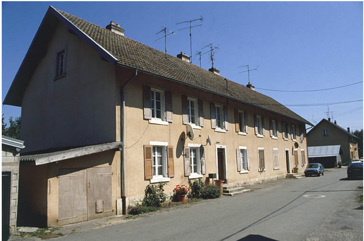
Logement ouvrier collectif.
