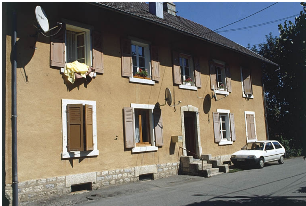
Façade antérieure d'un logement ouvrier à 4 appartements.
