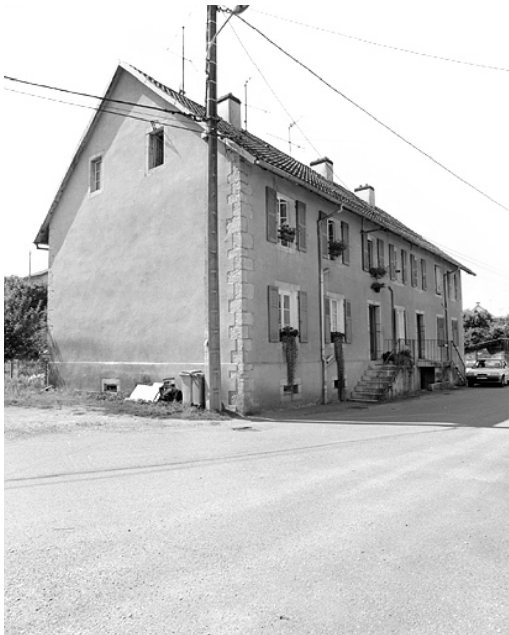
Logement ouvrier à 4 appartements et 2 entrées indépendantes.
