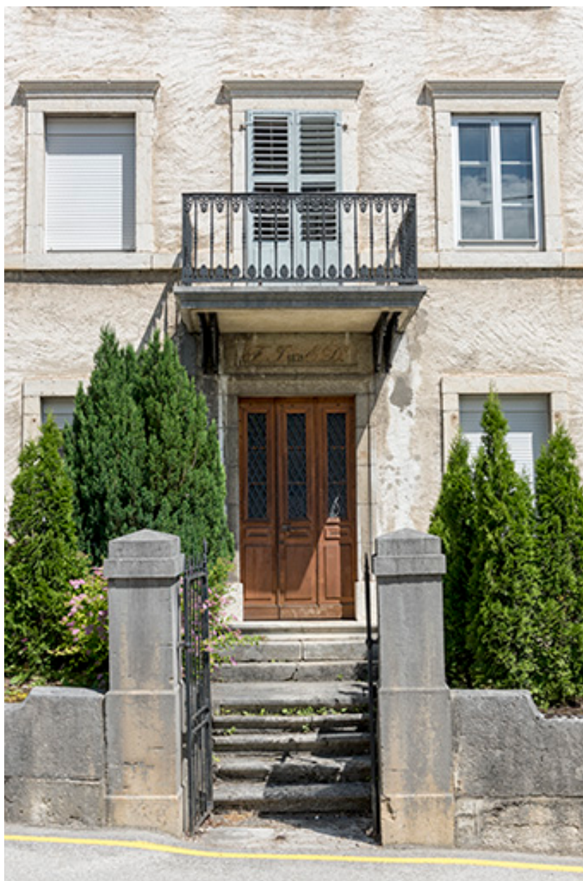
Façade antérieure : travée centrale.
