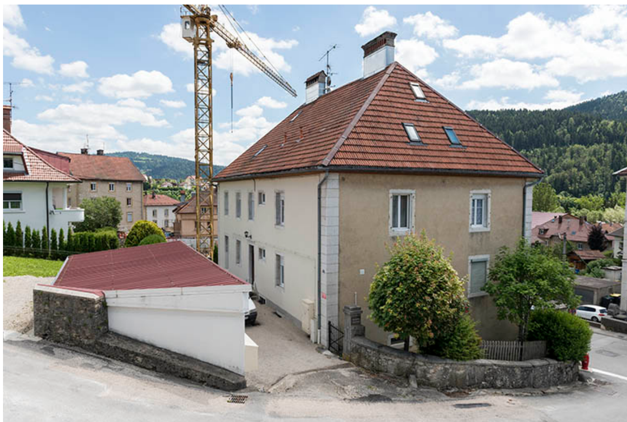
Façades postérieure et latérale gauche.
