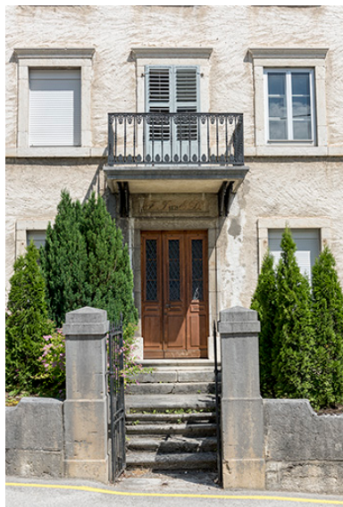
Façade antérieure : travée centrale.
