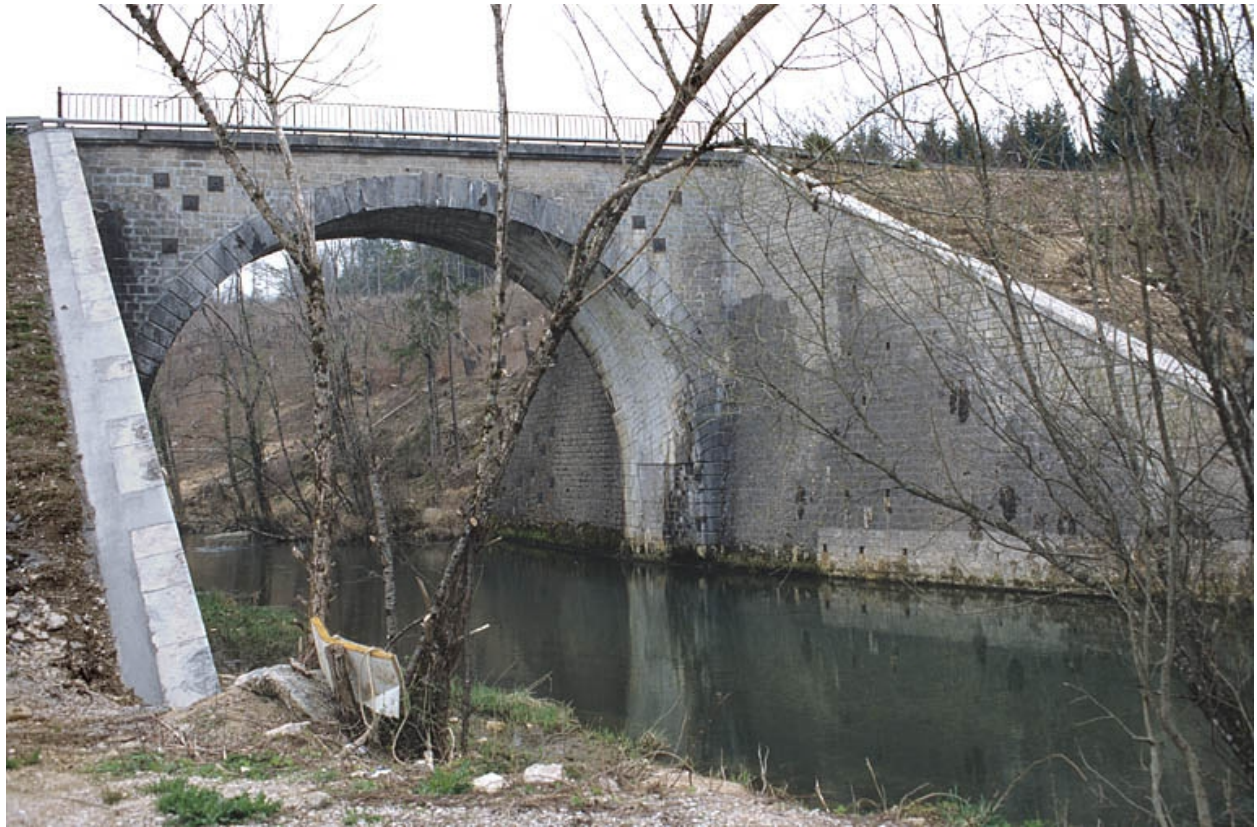
Pont sur l'Angillon : tête ouest (aval).
