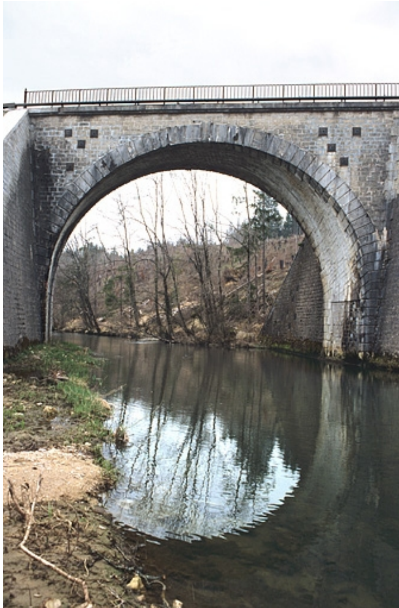
Pont sur l'Angillon : tête ouest (aval), appareil hélicoïdal.
