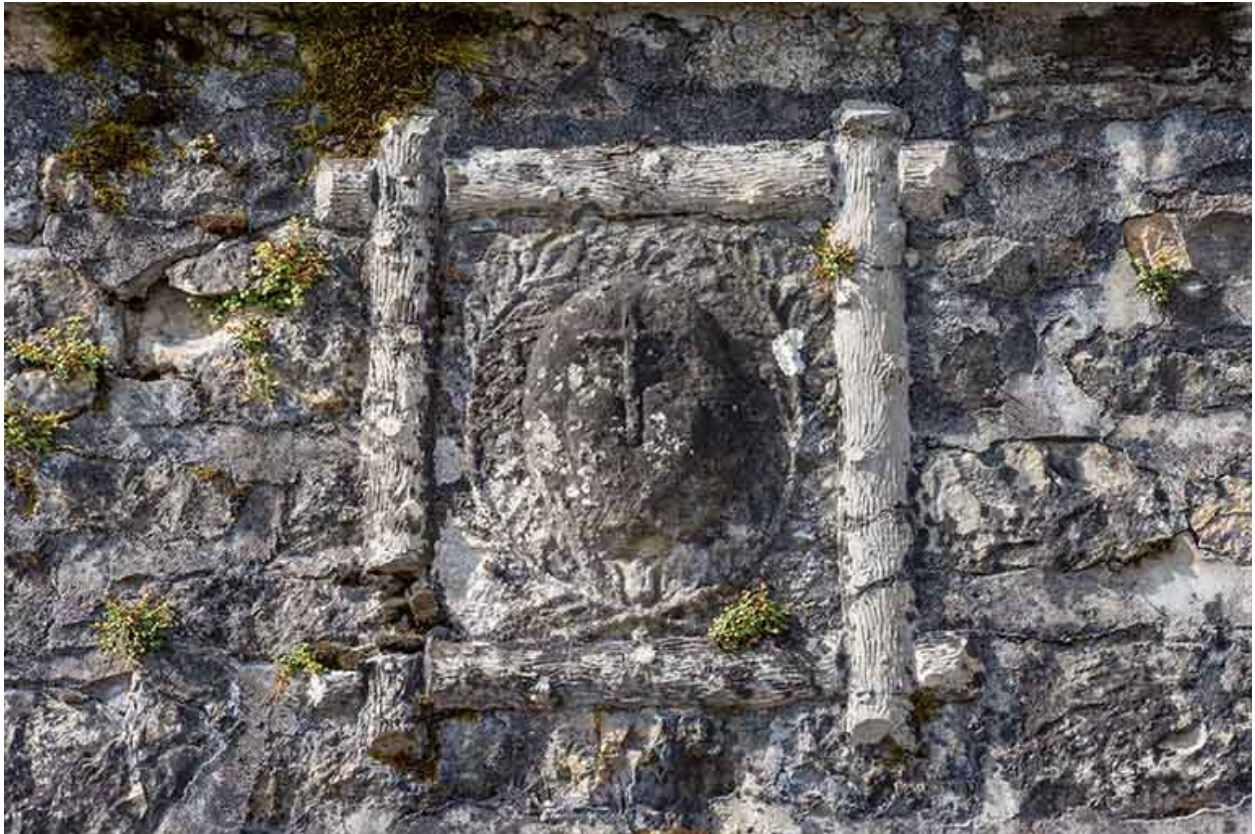
Détail de la façade du n° 37 : bas-relief.
