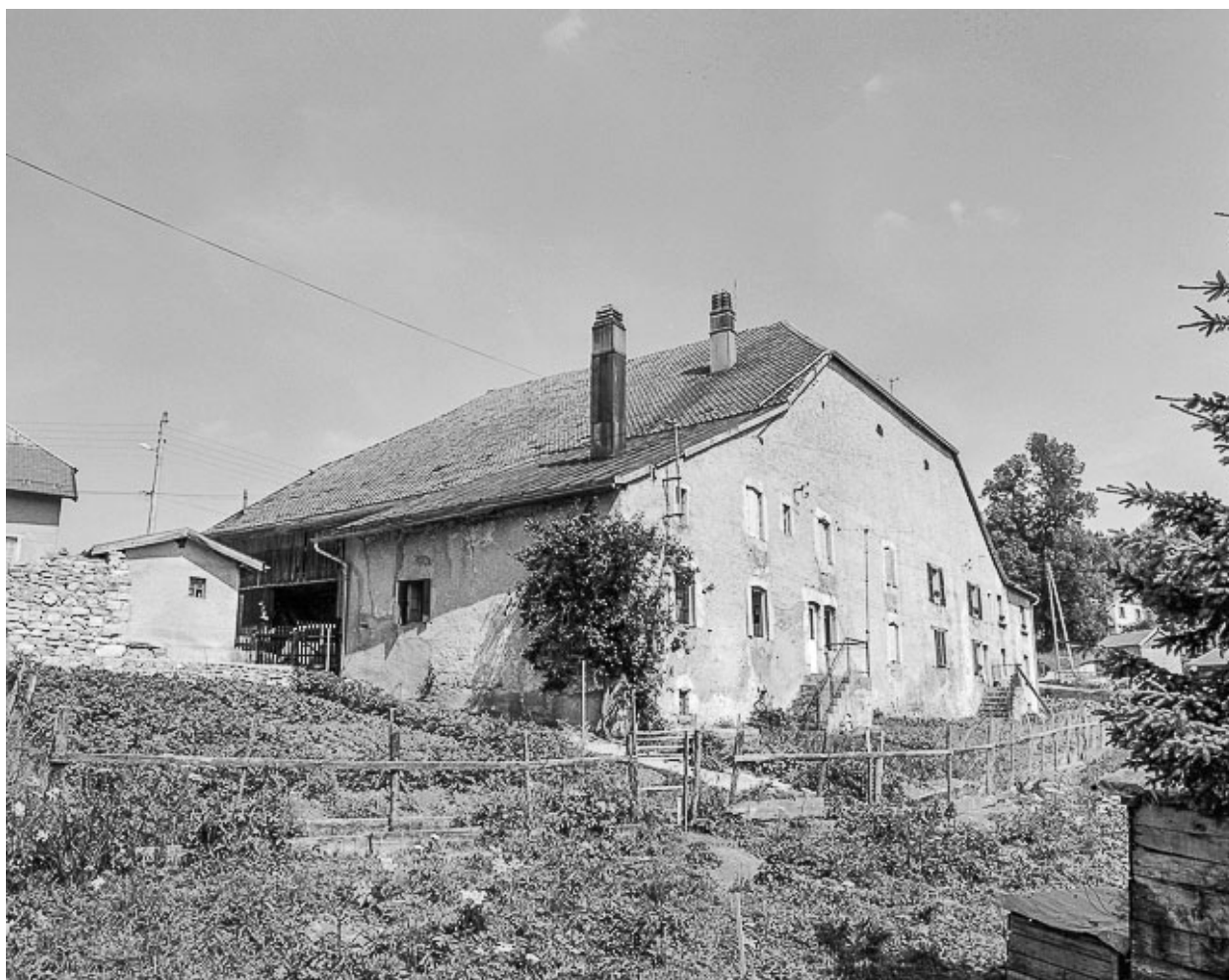
Façades antérieure et latérale gauche.
