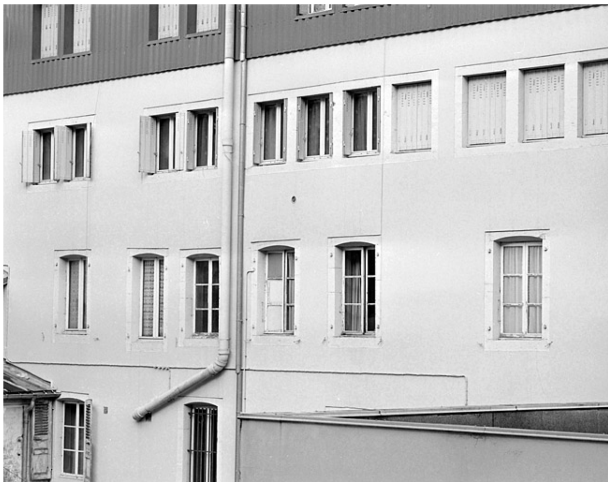
Elévation postérieure : fenêtres à linteau délardé en arc segmentaire du premier étage et fenêtres lunetières du deuxième.
