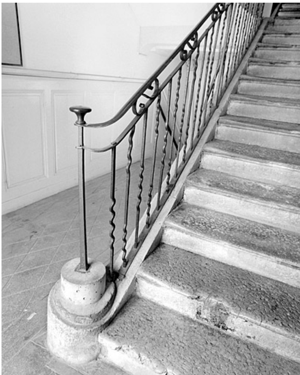
Rampe et départ d'escalier.
