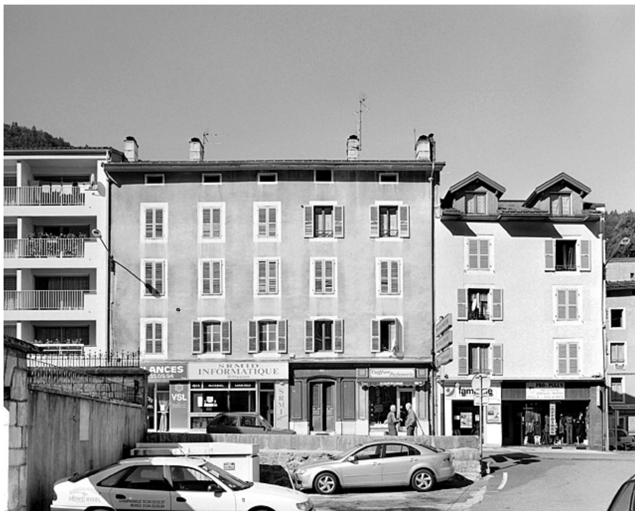
Vue d'ensemble de l'élévation antérieure.
