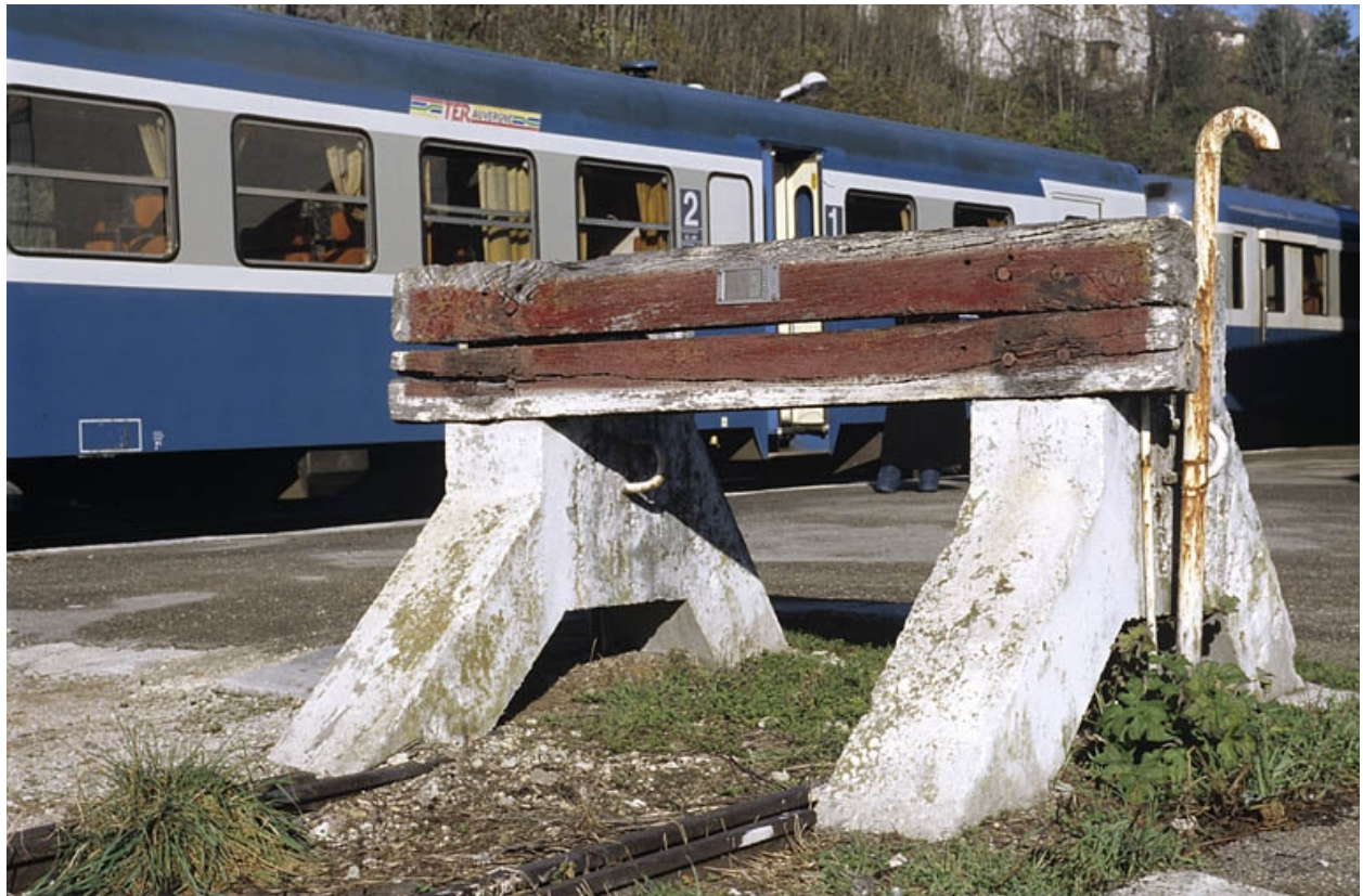
Butoir de la voie 5.
