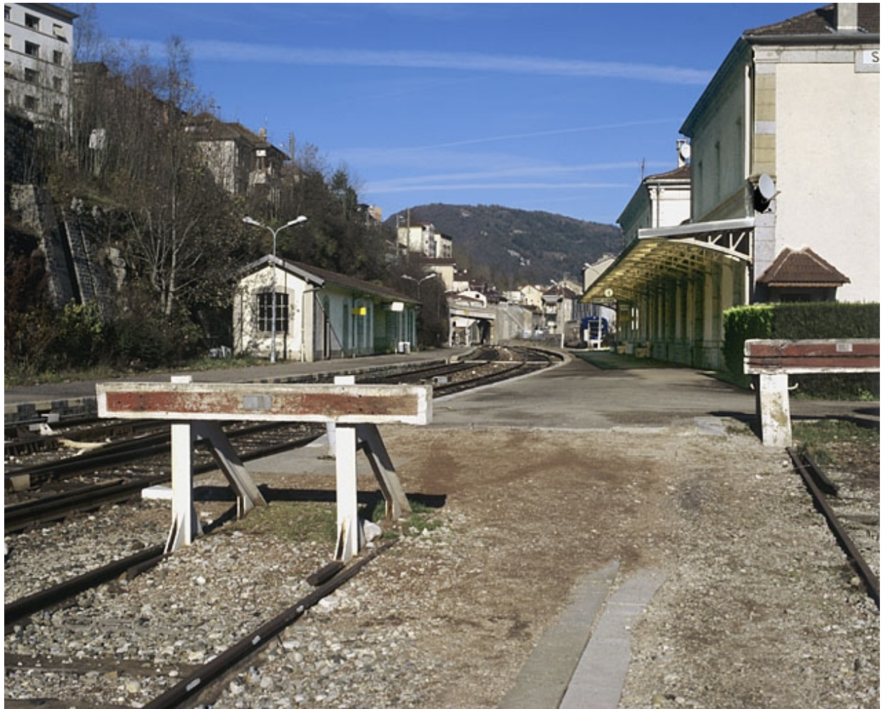
Vue d'ensemble des butoirs.
