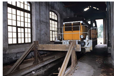
Exemple de butoir dans la remise ferroviaire (halle est). Phot. Yves Sancey IVR43_20053900798ZA
