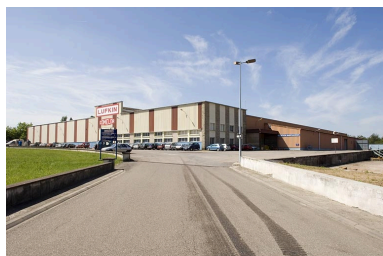
Usine de construction mécanique Comélor (Lufkin-Comélor 2), Fougerolles (rue de Luxeuil). Phot. Jérôme Mongreville IVR43_20097000322NUC2A
