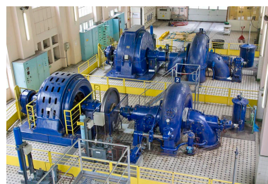
Groupe n° 2 (au premier plan) de la centrale hydroélectrique du Refrain (Charquemont), associant une turbine Escher-Wyss à un alternateur de la SACM avec excitatrice en tête d'arbre.
