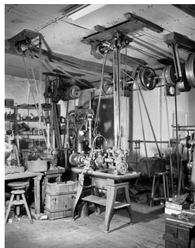
Usine d'horlogerie Arsène Cretin- l'Ange puis de matériel d'équipement industriel des Anciens Ets Charles Peccaud, Morbier (94-98 route Blanche) : intérieur de l'atelier avec un tour automatique suisse. Phot. Jérôme Mongreville IVR43_19913900821X
